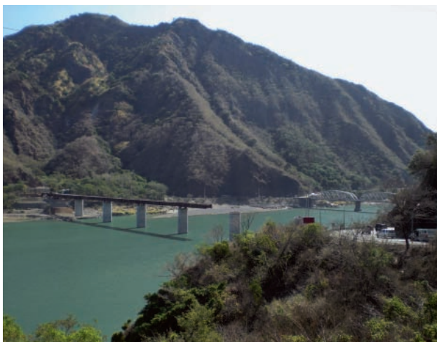
写真一五 桁送出し状況
