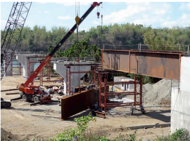
写真-1 架設状況
