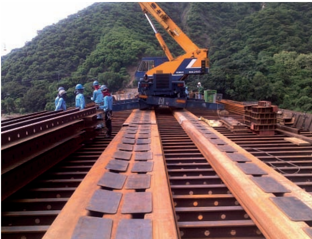
写真－10 合成床版上走行路
