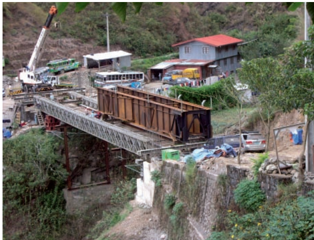
写真一八 桁縦取り状況
