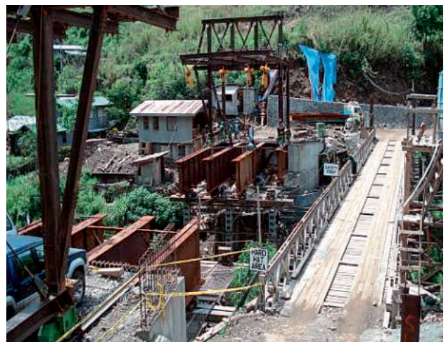
写真一六 架設状況（門型クレーン架設工法）
