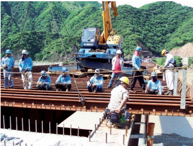
写真－11 合成床版の設置状況
