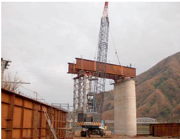
写真一四 クレーン架設状況
