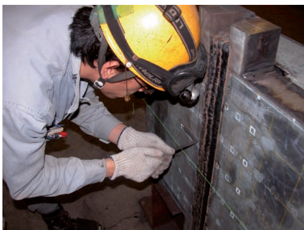
写真-8 角変形の測定状況
