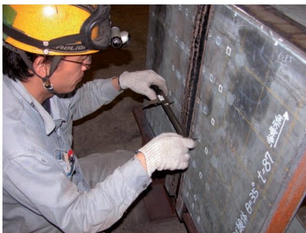
写真-7 溶接収縮測定状況
