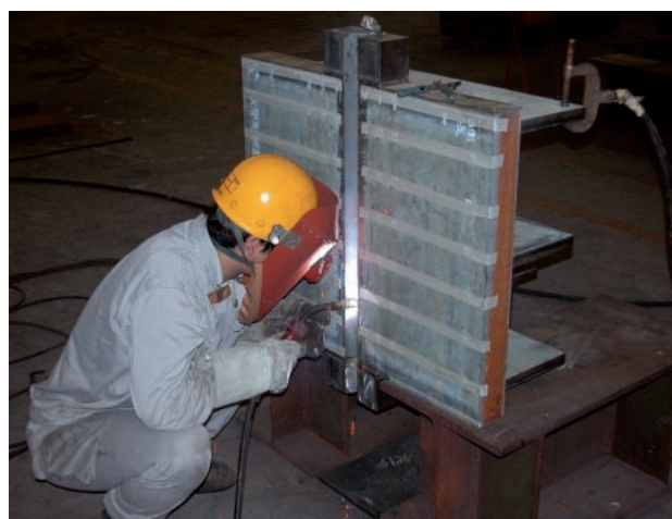
写真-6 試験溶接の状況
