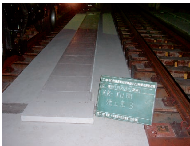
写真一3 現場施工完了
