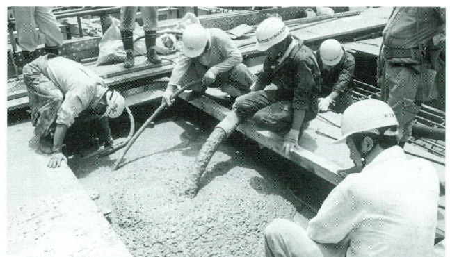
写真-6 剛結部コンクリート施工
