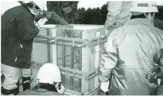
写真-4 現場施工試験状況
