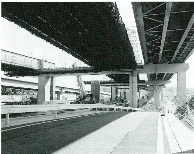
写真-2 P 324橋脚
