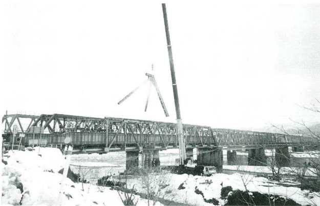
写真-8 トラス桁の撤去
