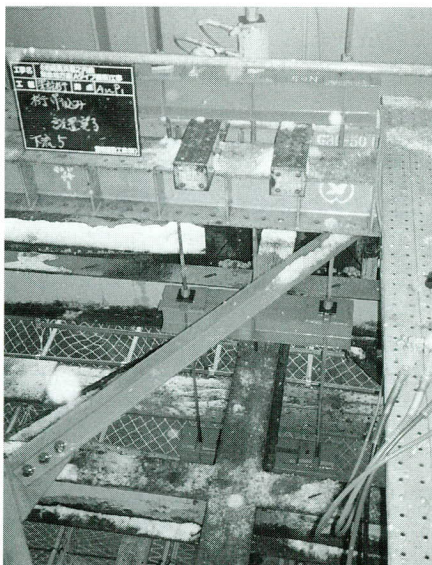
写真-5 トラス桁吊り下げ状況
