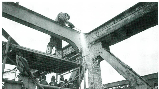
写真-11 トラス桁ガス切断状況
