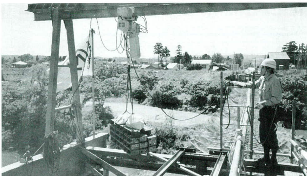
写真-13 テルハ作業状況
