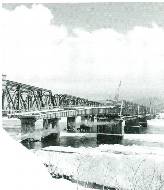
写真-1 旧越路橋全景
