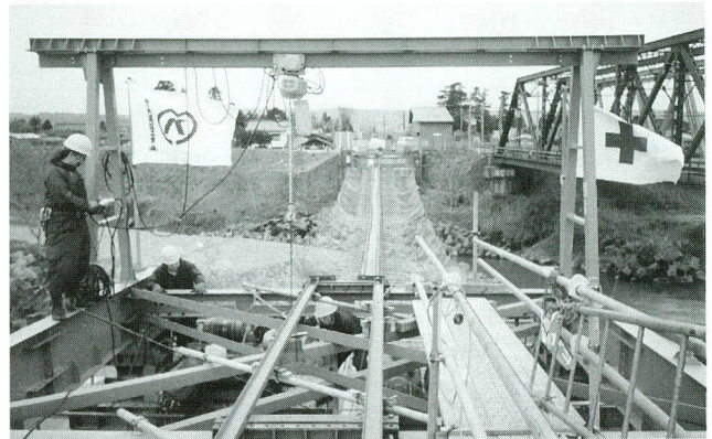
写真-12 テルハ据付状況
