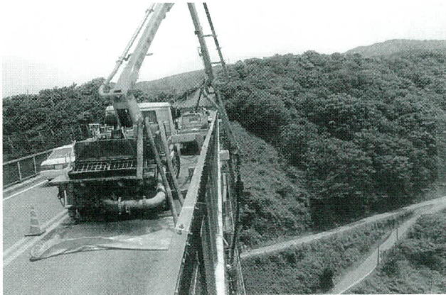
写真一6 橋面からのポンプ打設
