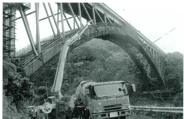
写真-5 橋下からのポンプ打設
