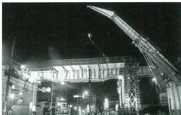
写真-3 工事桁架設
