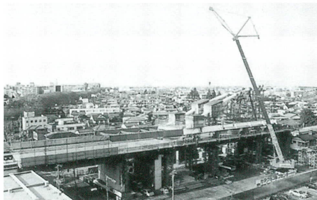
写真-2 桁組立て・縦移動ヤード
