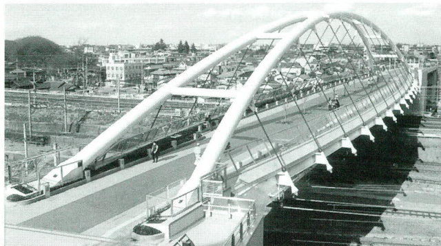
写真-1 大宮ほこすぎ橋全景
