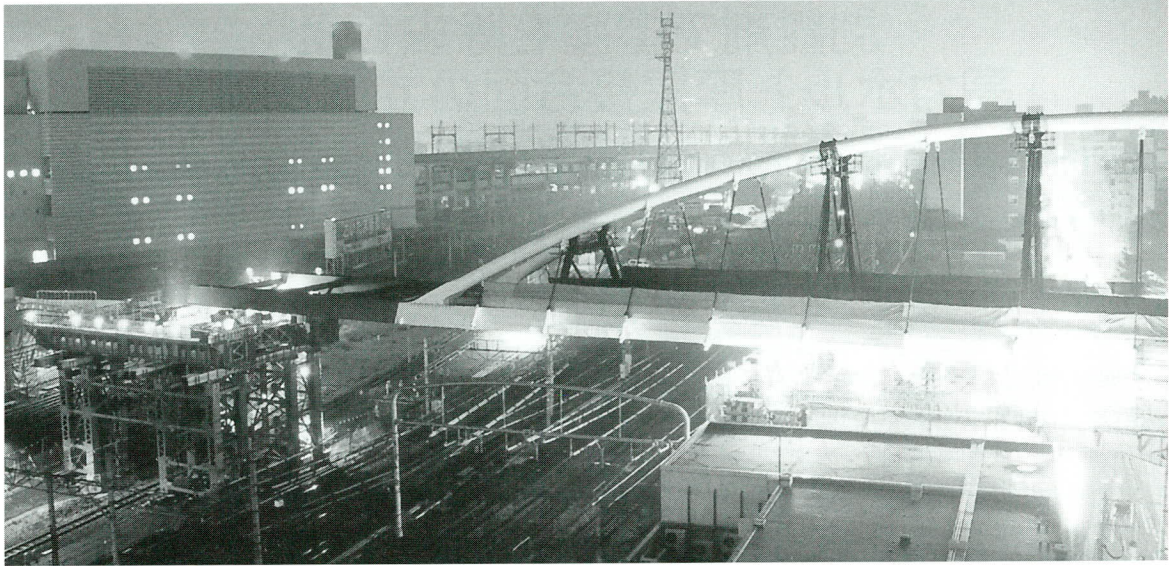
写真-11 第2回桁縦移動完了
