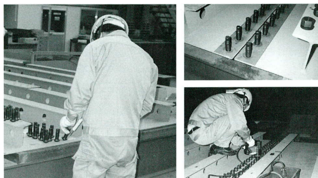
写真-2 接着剤を用いた底鋼板継手部の施工
