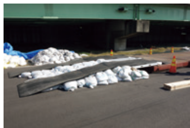
軽量土嚢によるスロープ構築
