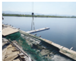
桁下の足場への取込み
