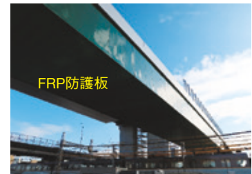
FRP防護板 寺田高架橋（底板・側板） (国土交通省 令和3年度竣工)
