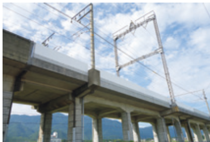
JR湖西線におけるFRP製壁高欄設置状況 (西日本旅客鉄道)
