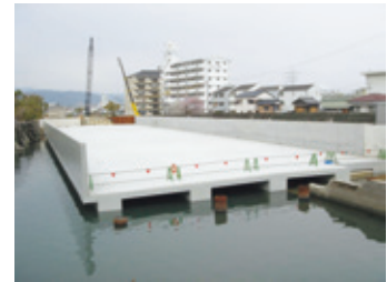
潮新町線橋梁 (栈橋構造への適用) (高知市 平成17年度竣工)
