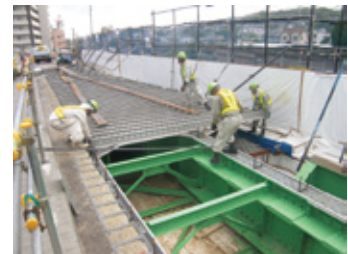
菅公橋 (軽さを生かした人力施工) (近畿地方整備局 平成26年度竣工)
