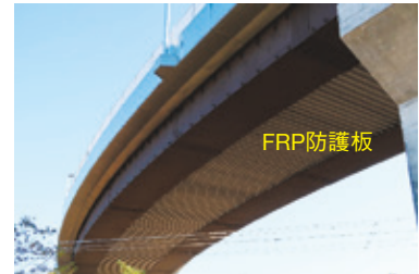
FRP防護板 古間木橋 (青森県 令和2年度竣工)
