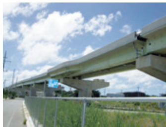
豊見城高架橋 (沖縄総合事務局 平成20年度竣工)
