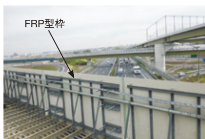
久喜白岡ランプ（高速道路本線上への適用） (NEXCO東日本 平成24年度竣工)
