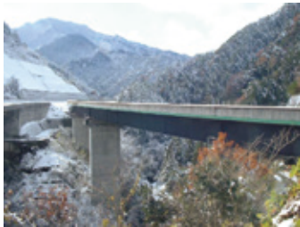
高知自動車道 松久保橋 (旧日本道路公団 平成9年度竣工)
