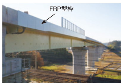
大網白里高架橋（JR上送り出し架設への適用） (NEXCO東日本 平成23年度竣工)
