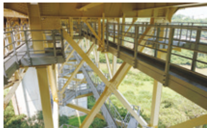
福地川橋上部工検査路 (トラス橋への設置) (NEXCO西日本 平成30年度竣工)
