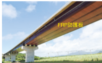
FRP防護板 下田原大橋 (沖縄県 令和2年度竣工)
