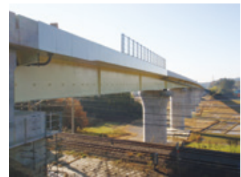
大網白里高架橋 (送り出し架設への適用) (NEXCO東日本 平成23年度竣工)
