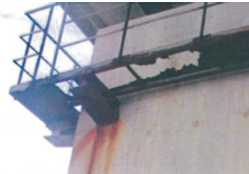
鋼製検査路の腐食による損傷の例
