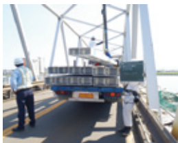
検査路の荷卸し (ユニック車)
