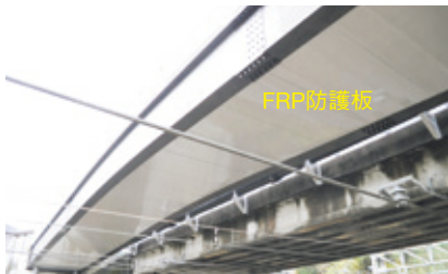
FRP防護板 山本陸橋（鉄道こ線橋） (和歌山県広川町 平成25年度竣工)
