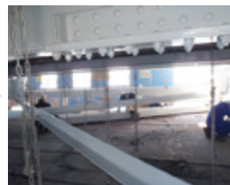
桁下足場上での移動
