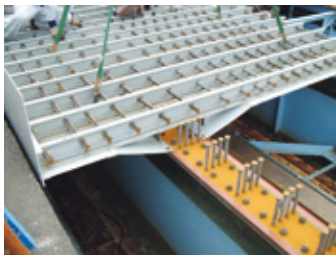
兔尻橋 (床版打替えへの適用) (秋田県 平成17年度竣工)
