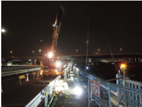
写真-1 (その2) 工事 夜間施工状況
