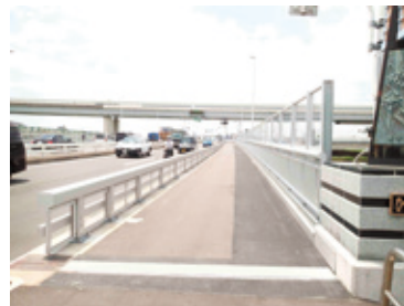
写真-5 (その1) 工事 橋面 (施工完了)
