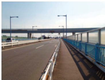
写真-2 (その1) 工事 橋面 (施工前)
