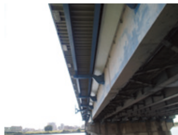
写真-7 (その2) 工事 歩道床版下面 (施工完了)
