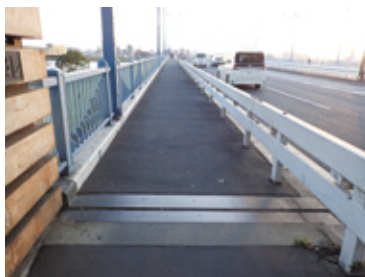
写真-3 (その2) 工事 橋面 (施工前)
