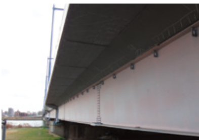
写真-4 (その2) 工事 歩道床版下面 (施工前)
