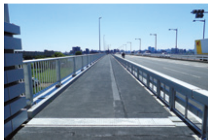
写真-6 (その2) 工事 橋面 (施工完了)
