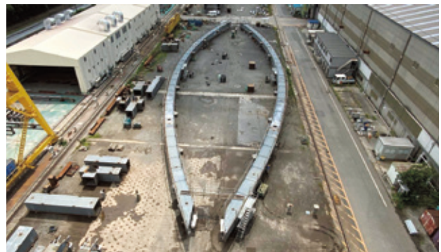
図-3 第2回仮組立（アーチ上部）
