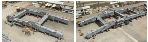
図-2 第1回仮組立（アーチ下部）
