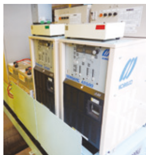
写真-6 溶接電源
