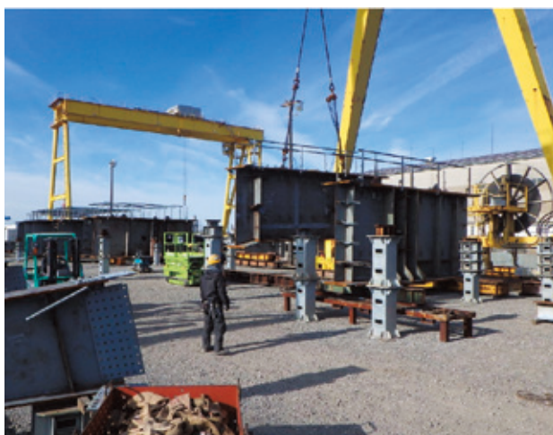
図-6 新架台を使った仮組立 (2)
