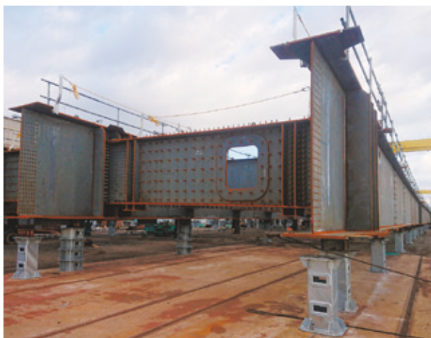
図-5 新架台を使った仮組立 (1)
