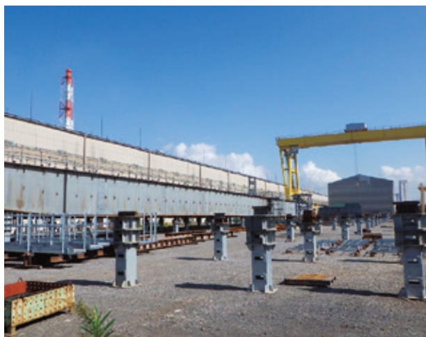
図-8 新架台の設置状況 (仮組立前)
