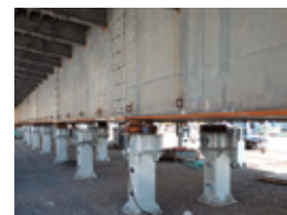
図-3 架台の設置状況（左：旧架台 右：新架台）
