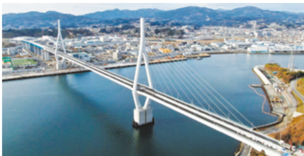
写真-1 全体写真（施工完了後）
