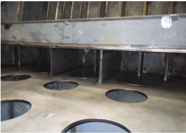
写真-6 溶接が難しい箇所 (基部ブロック)
