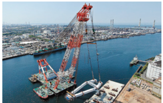
写真-14 主塔の浜出し (下段ブロック)
