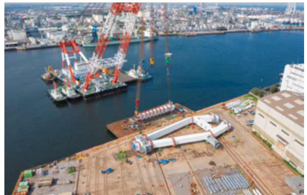
写真-13 主塔の浜出し (上段ブロック)
