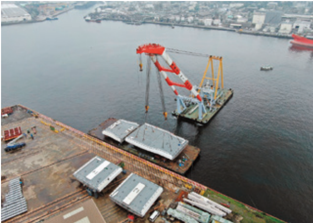
写真-15 補剛桁の浜出し
