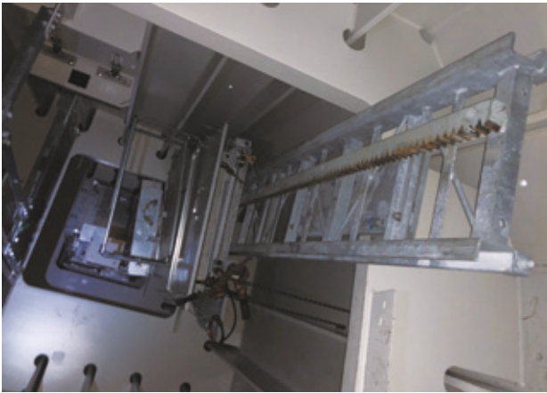
写真-10 主塔内への付属物の設置 (エレベーター)
