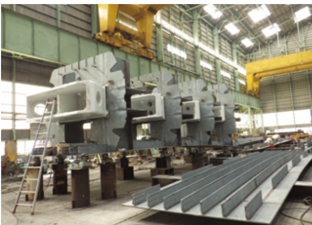
写真-7 ケーブル定着部の組立
