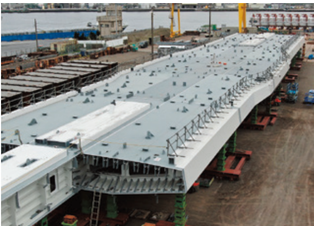
写真-11 補剛桁の仮組立
