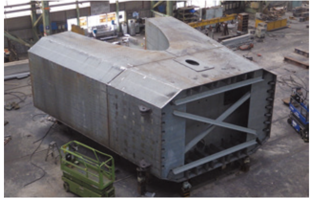
写真-8 主塔隅角部の一体組
