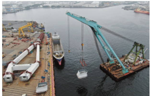
写真-12 主塔の浜出し (基部)
