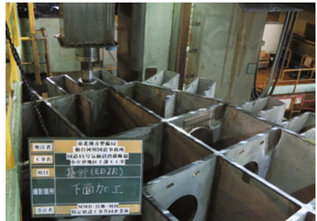
写真-5 大型立旋盤での基部加工
