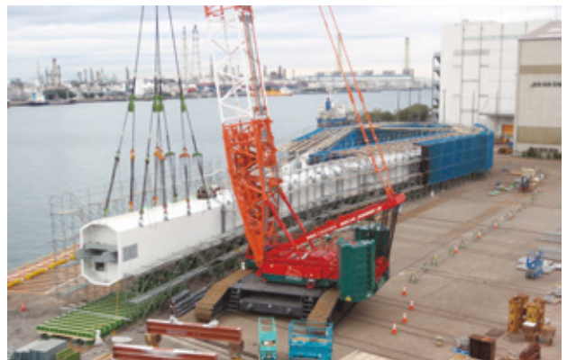
写真-9 主塔の仮組立・地組立
