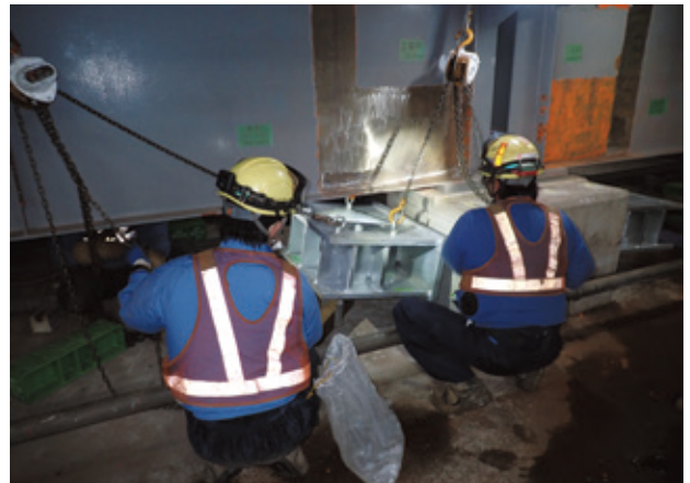
写真-8 仮受ブラケット設置状況
