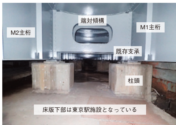
写真-1 高架橋上部の状況
