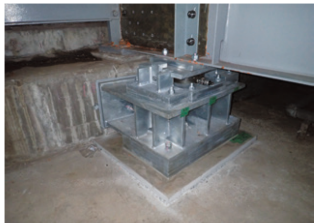
写真-9 仮受設備設置完了
