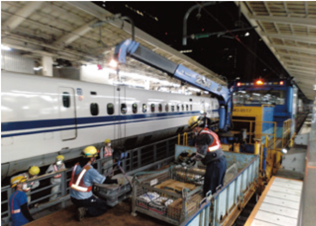
写真-6 東京駅での部材荷下ろし状況
