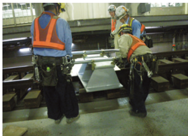
写真-3 軌道横断状況
