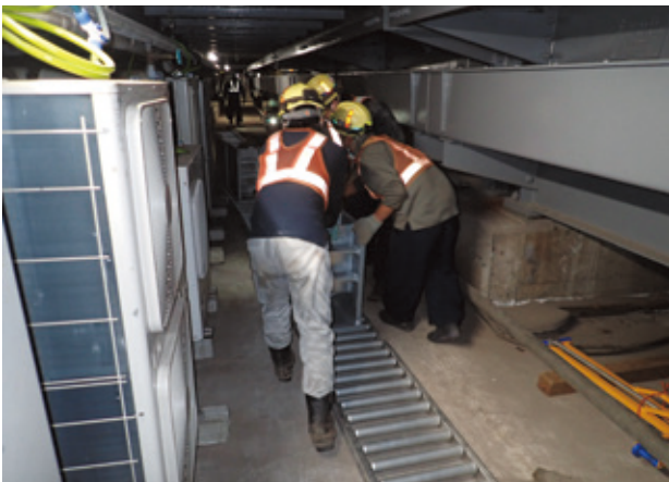
写真-7 床版上運搬状況
