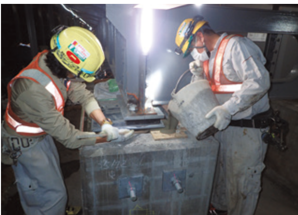
写真-12 PEG-15 打設状況
