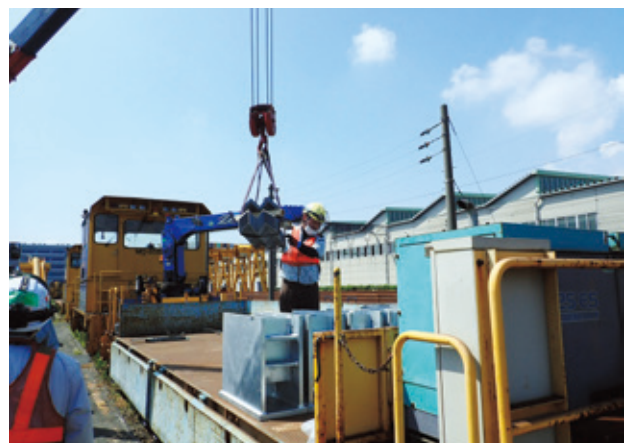
写真-5 大井車両基地での積込み作業
