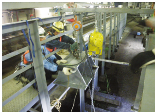
写真-4 設置階荷下ろし状況
