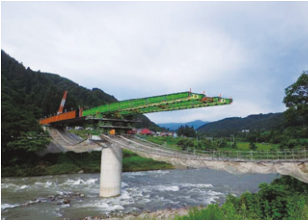
写真-11 送出し状況写真
