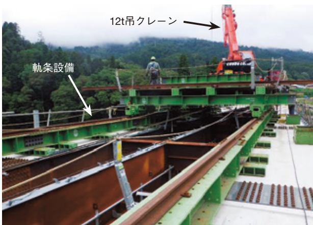
写真-8 仮設備解体状況
