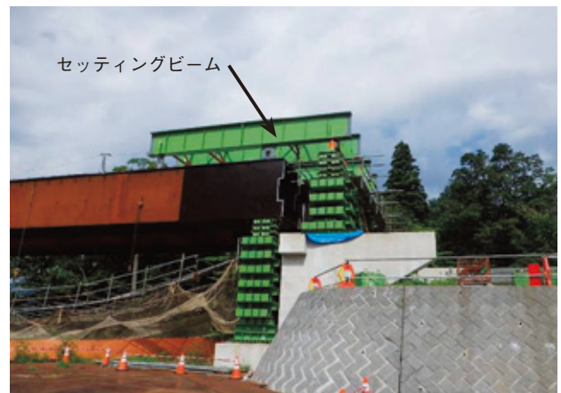
写真-9 桁降下状況
