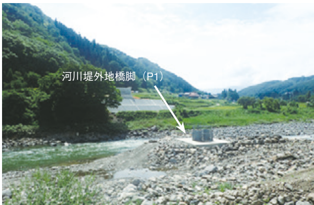
写真-1 河川堤外地橋脚（下部工施工中）
