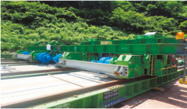
写真-5 軌条設備と自走台車設備
