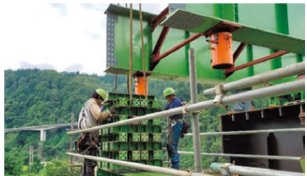
写真-10 油圧ジャッキ吊り下げ状況
