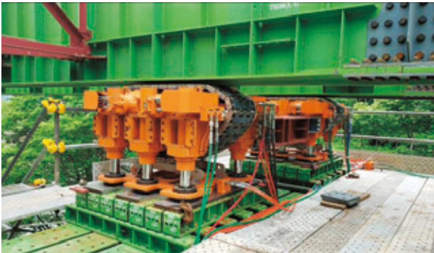
写真-6 駆動シンクロジャッキ
