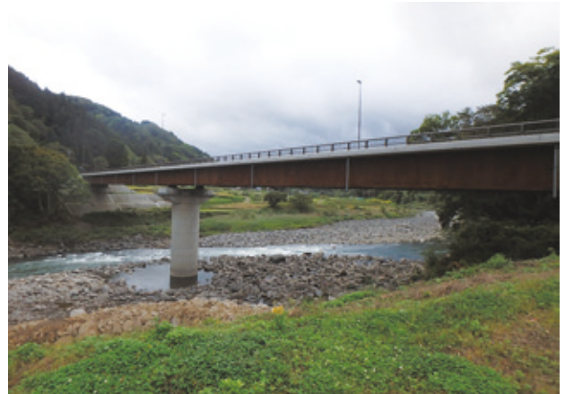
写真-12 完成写真
