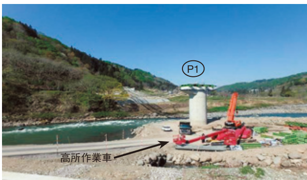
写真-3 仮設備組立状況
