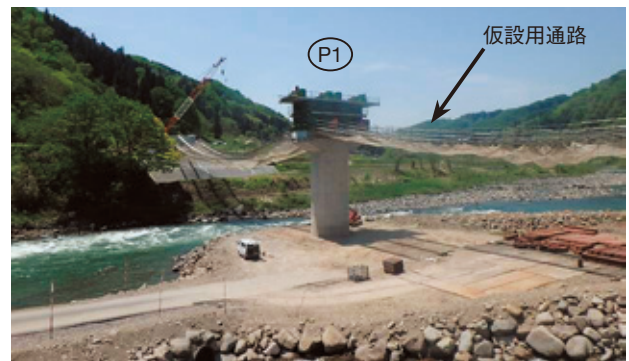
写真-4 ワイヤブリッジの設置
