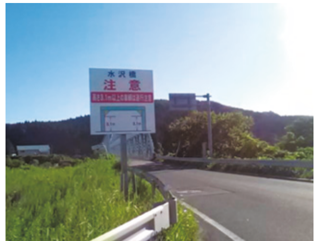
写真-1 旧水沢橋
