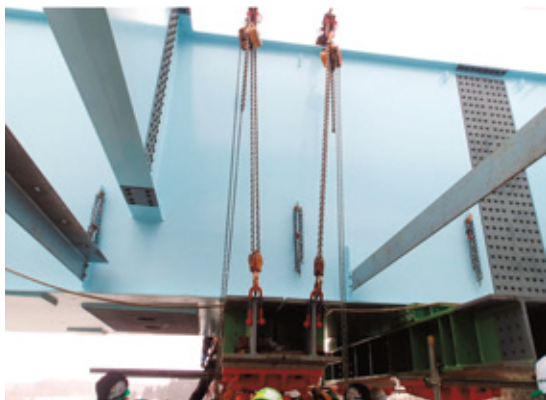
写真-2 盛替え状況写真
