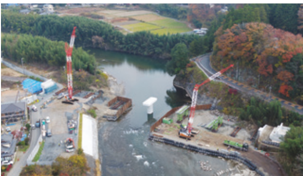
写真-3 クレーン設置状況
