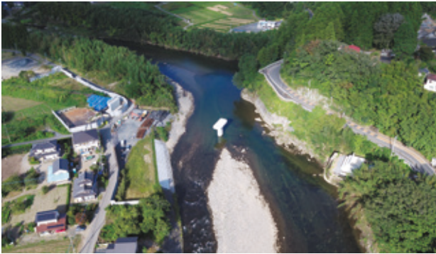
写真-1 築島設置前
