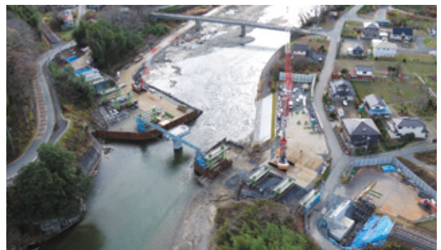
写真-5 ベント組立状況
