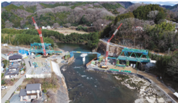
写真-9 第2回桁架設状況
