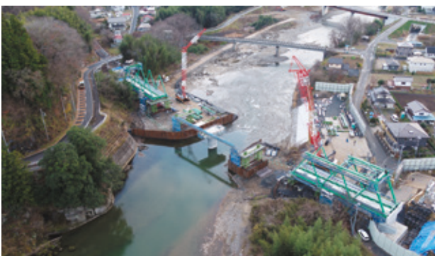
写真-7 第1回桁架設状況
