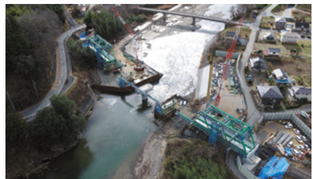
写真-8 第1回桁架設完了
