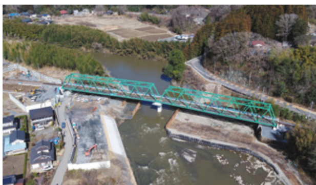
写真-12 桁架設完了
