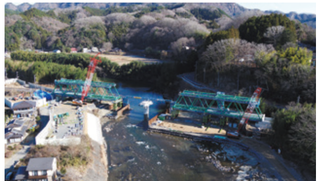
写真-10 第2回桁架設完了
