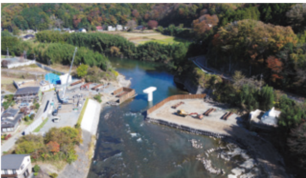
写真-2 築島設置後
