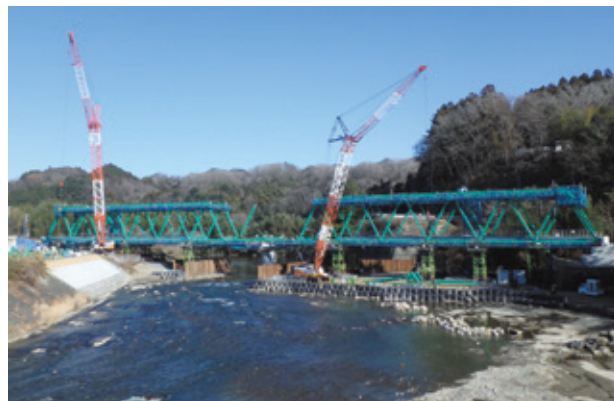
写真-11 架設状況
