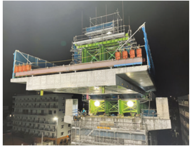
写真-24 主縦取り状況
