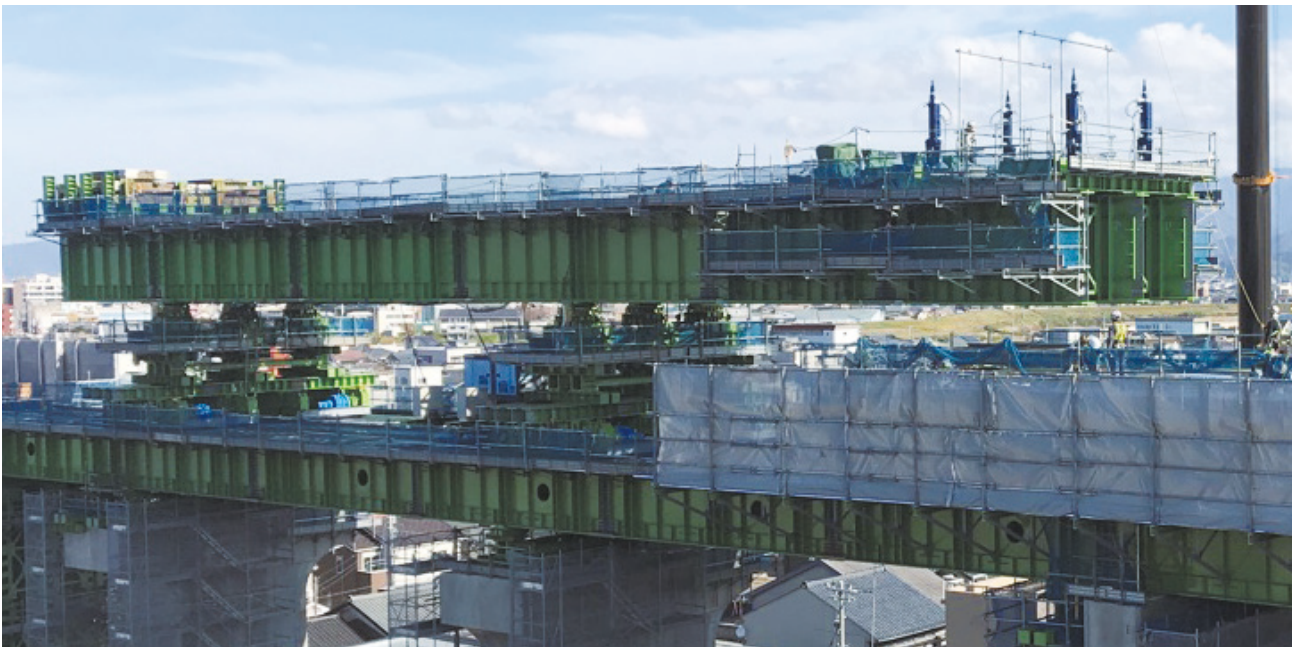
写真-9 吊り下げ台車設備
