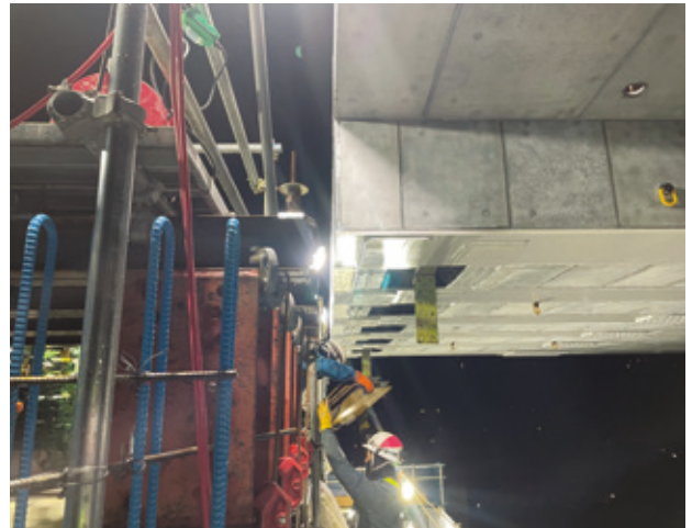
写真-25 主桁降下状況
