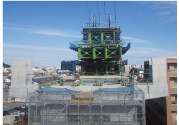
写真-16 軌条桁縦取り架設前
