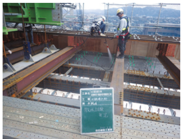
写真-23 散水試験実施状況
