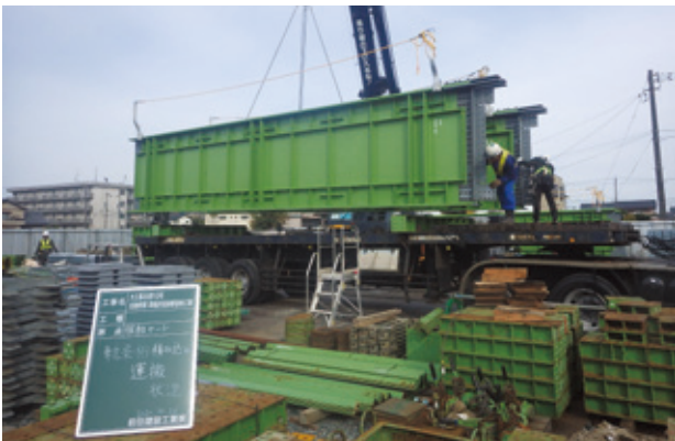
写真-5 軌条桁運搬状況
