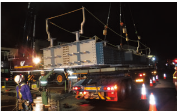
写真-19 主桁積み込み状況
