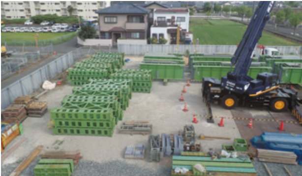
写真-4 仮組ヤード機材地組状況
