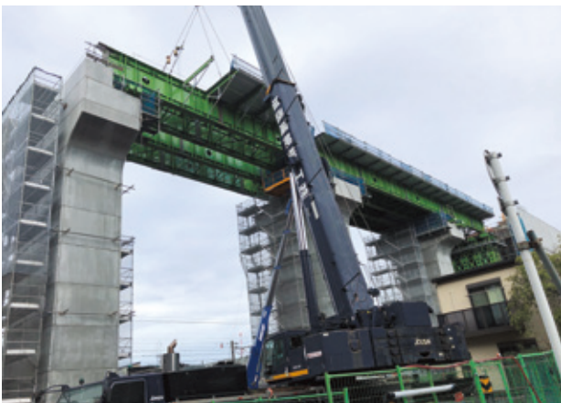
写真-7 軌条桁架設状況
