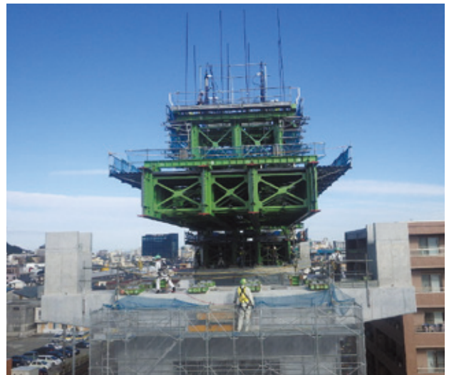
写真-17 軌条桁縦取り架設完了
