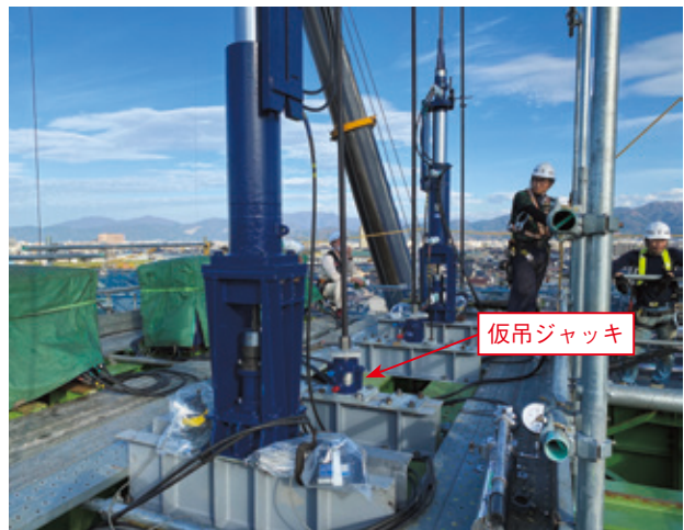
写真-15 仮吊りジャッキ設置状況
