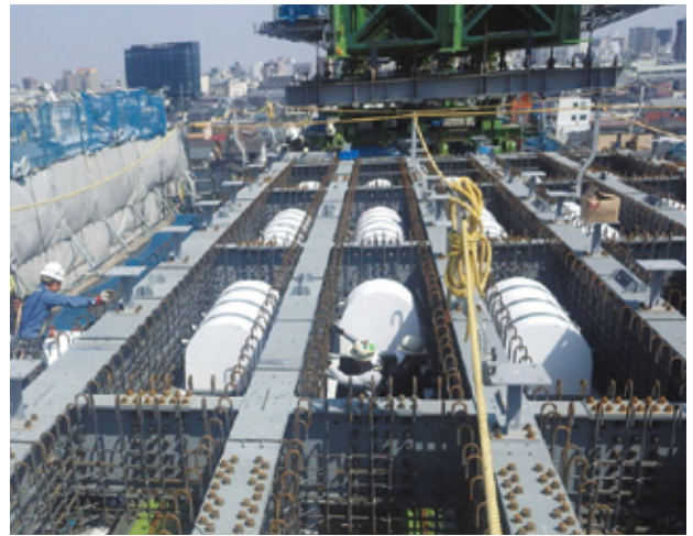
写真-21 埋設型枠取り付け状況
