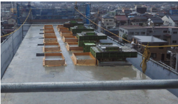
写真-6 仮支承設置状況
