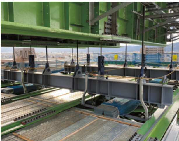
写真-14 吊り天秤設備設置状況
