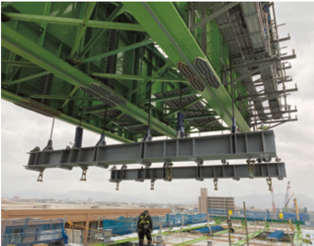
写真-13 吊り天秤設備
