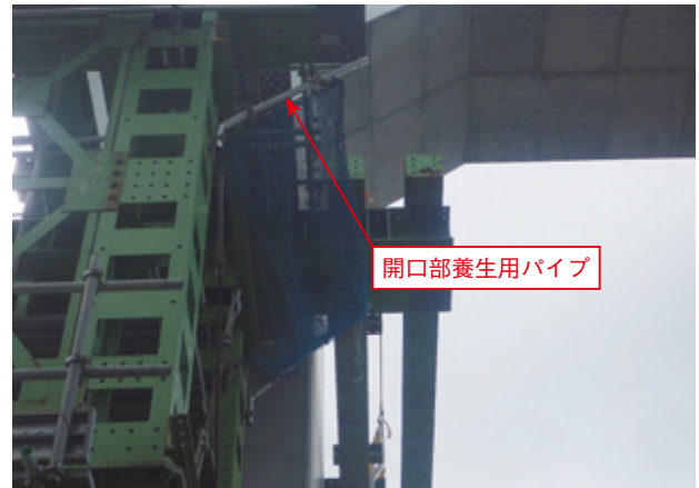
写真-2 桁式支保工頂部 養生状況-1
