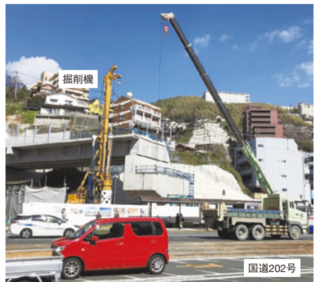
写真-2 基礎杭設置状況
