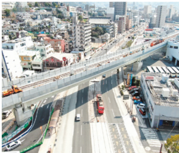
写真-5 架設完了
