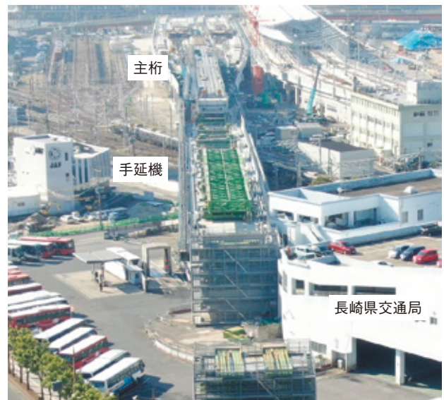
写真-4 送り出し部材組立状況
