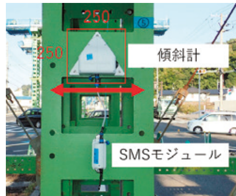
図-2 傾斜計のベントへの設置状況
