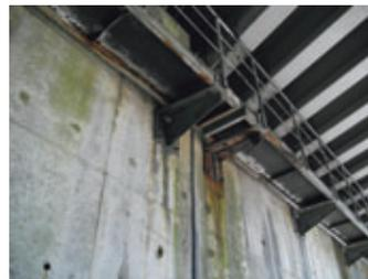
鋼製検査路の腐食による損傷の例
