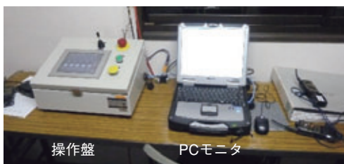
写真-5 ジャッキアップシステム
