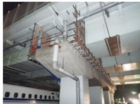
写真三 ブラケット足場
