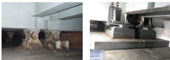
写真二 施工前、完了
