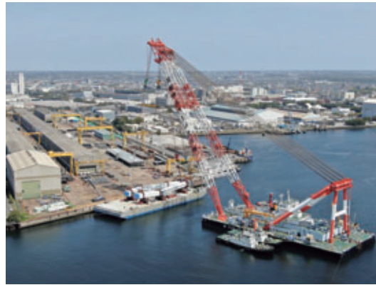
図-2 主塔浜出しの様子
