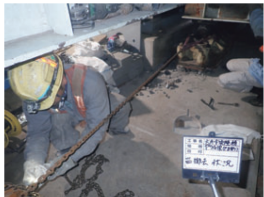
写真-6 既設支承撤去状況
