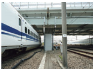
写真一 P7橋脚全景
