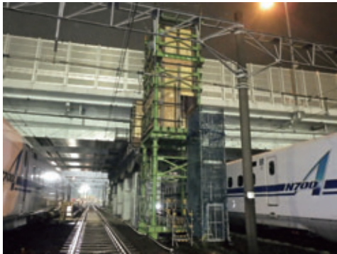
写真-4 作業構台
