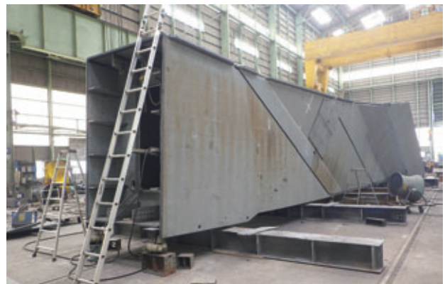
図-10 交差部組立①
