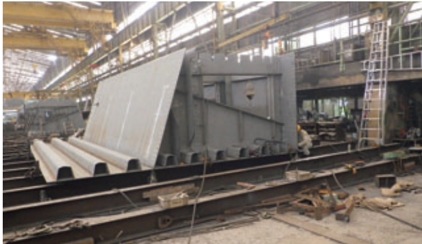
図-6 補剛桁一体組立
