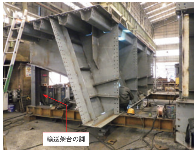
図一20 輸送架台④（溶接時）
