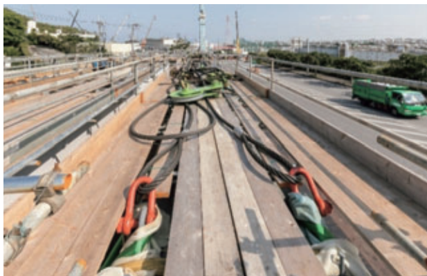
図-5 大ブロック桁上の玉掛設備の事前設置状況
