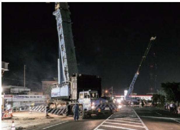
図-4 大型クレーンの自走状況
