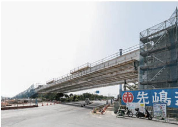
図-10 架設完了状況
