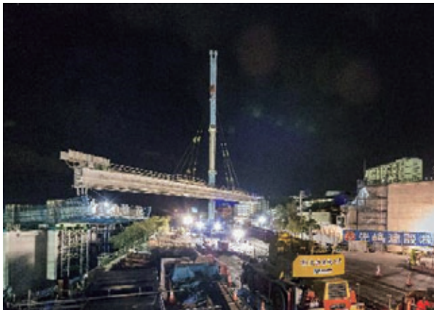
図-9 大型クレーン桁旋回状況
