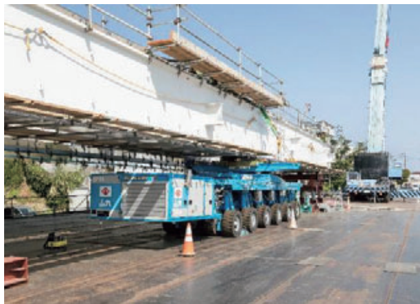
図-6 多軸台車への支持荷重の受け替え作業状況
