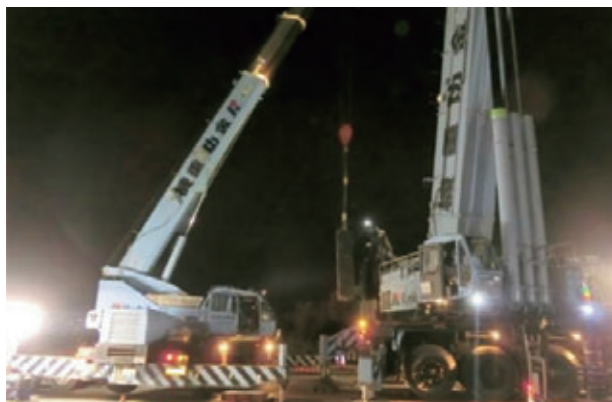
図-7 多軸台車への支持荷重の受け替え作業状況
