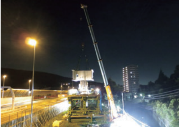
図一五 剛結部鋼製橋脚架設状況
