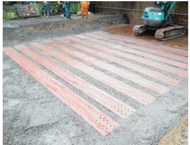
図-11 強化路盤状況
