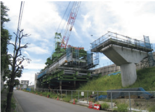
図一六 トラベラクレーンによる鋼桁架設状況
