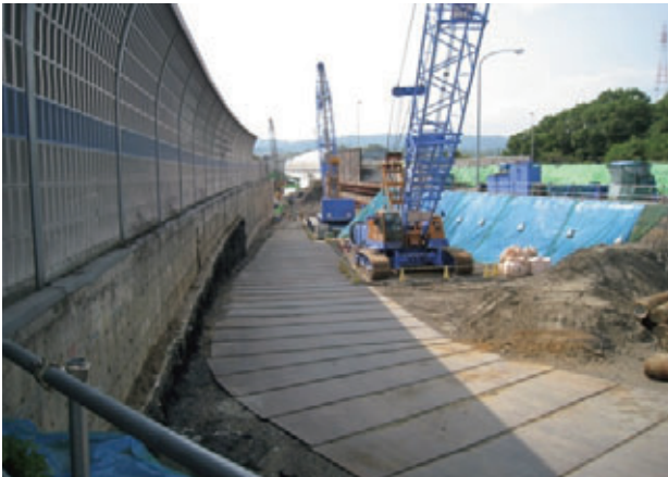
図-9 軌条部ヤード状況
