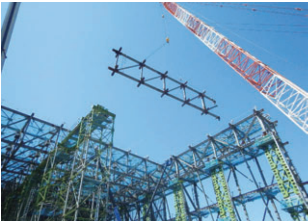
写真-10 トラス建方
