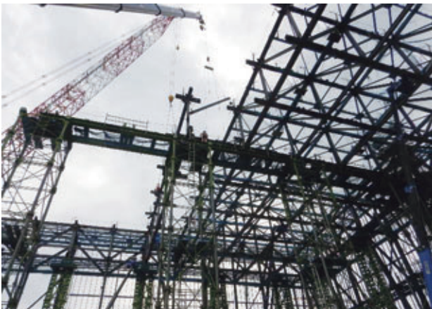
写真-11 繋ぎ梁取付
