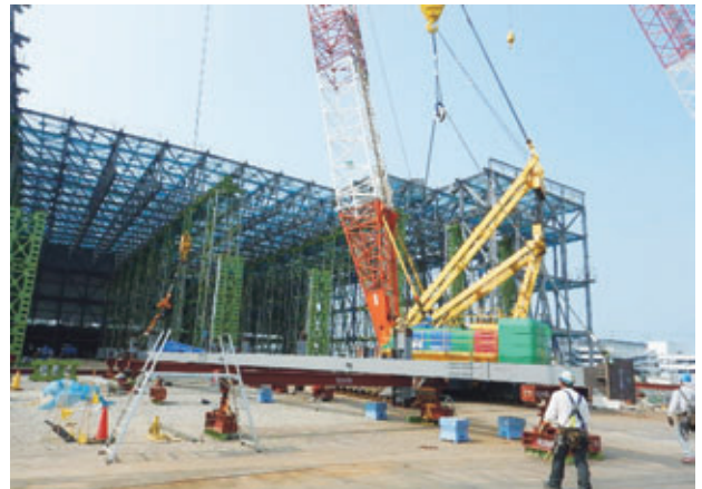
写真-6 V字柱建て起こし
