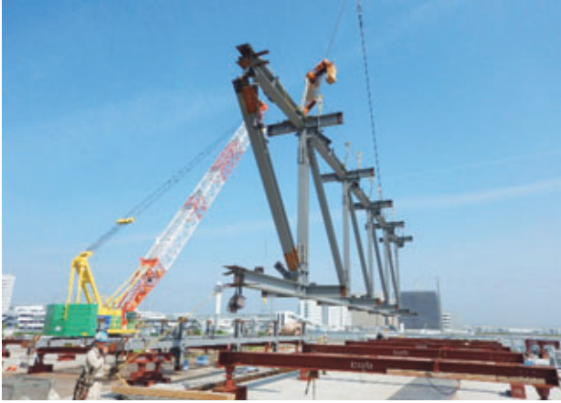
写真-9 トラス縦起こし
