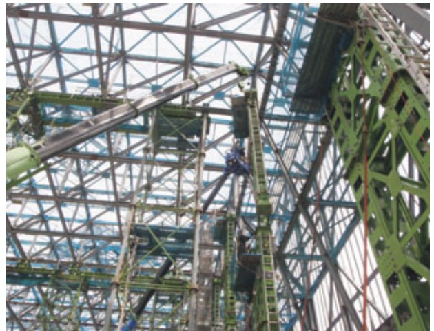
写真-5 パネルベント解体の様子
