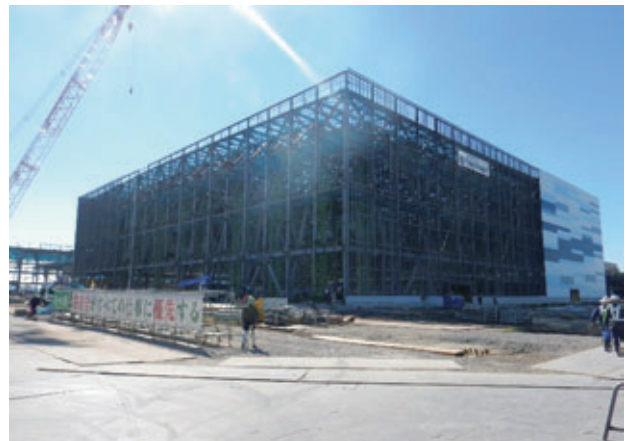
写真-17 工事完了後
