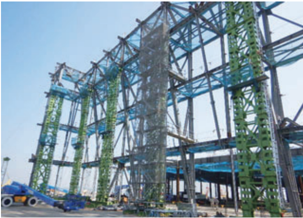
写真-3 パネルベント全景
