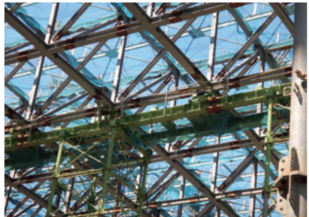
写真-1 仮受け桁
