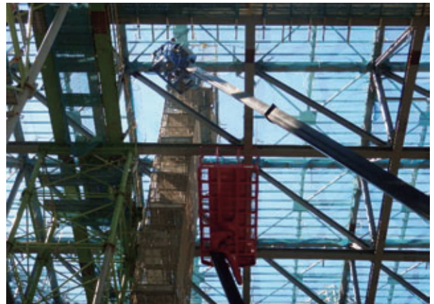
写真-16 後施工部材取付
