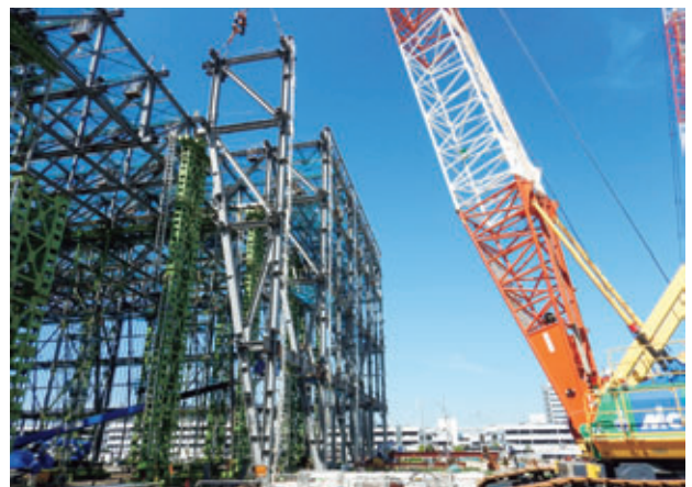
写真-7 V字柱建方
