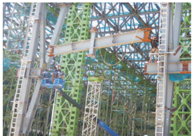
写真-8 耐風梁取付
