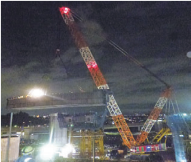
図-3 鋼桁大ブロック夜間一括架設状況
