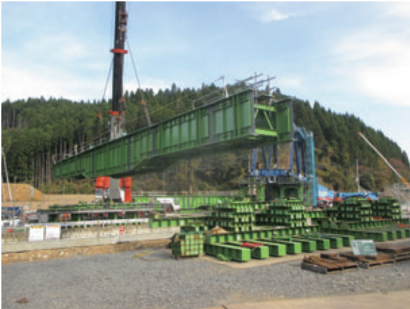
写真一四 B2,B3,B4ベント設備組立
