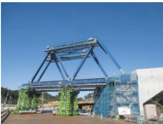
写真-3 左岸側本設桁組立完了
