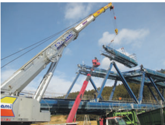
写真一六 右岸側からの本設桁架設
