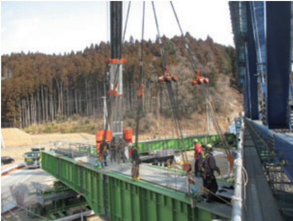
写真一八 B2,B3ベント工事桁玉掛け状況
