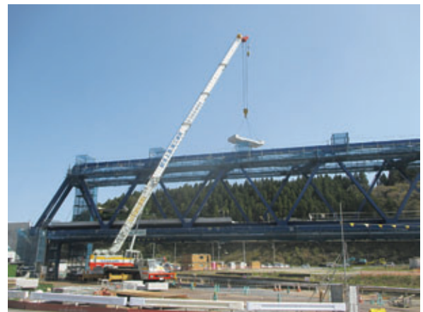
写真一〇 プレキャスト床版架設
