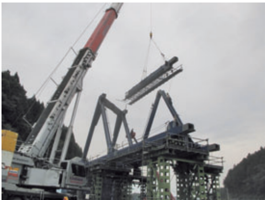
写真-2 本設桁組立
