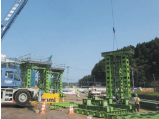
写真-1 ベント設備組立
