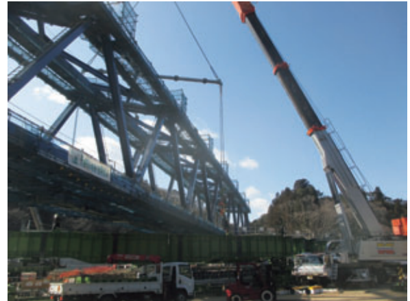
写真一九 B4ベント工事桁撤去（吊天秤玉掛け時）
