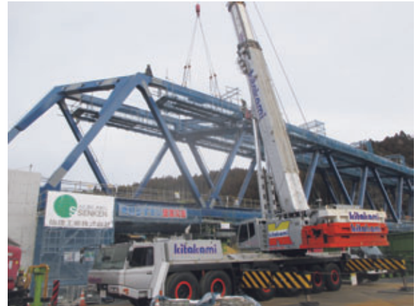
写真一七 最終ブロック閉合時
