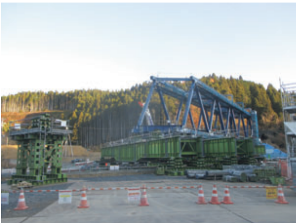
写真一五 左岸側からの本設桁組立完了
