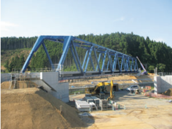
写真-12 本設桁架設完了
