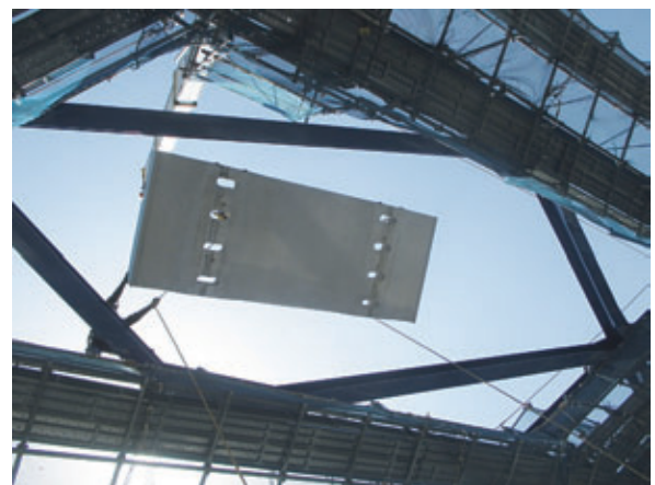
写真一一 上弦材支床版通過時
