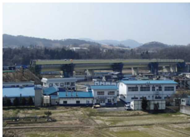
写真-12 送り出し完了
