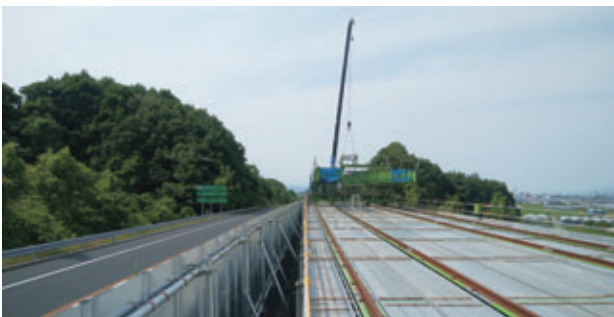
写真-2 手延べ機組立状況
