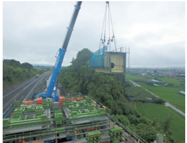
写真-3 桁組立状況 (高速道近接)
