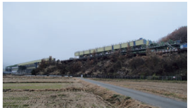
写真-4 桁組立状況 (縦送り)
