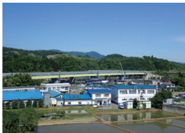
写真-13 架設完了
