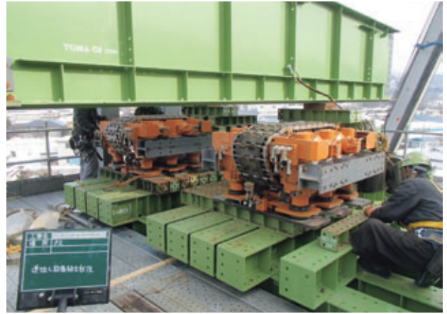
写真-8 シンクロジャッキ(駆動)
