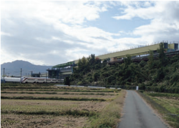
写真-7 第1回送り出し完了
