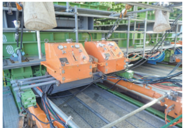
写真-9 水平ジャッキ(台車)
