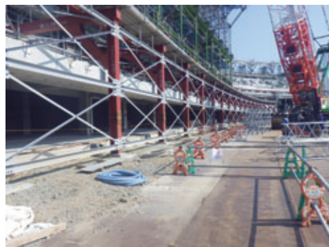
写真-13 軌条用構台
