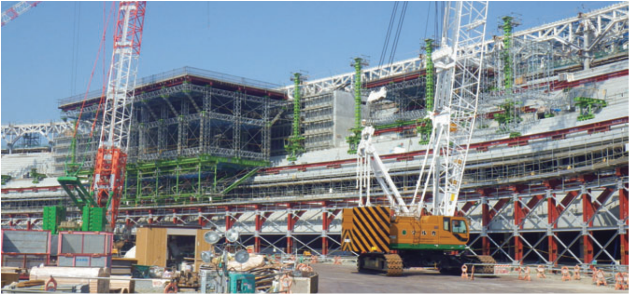
写真-8 移動ステージ外観①
