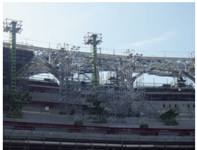
写真一7 中央部ベントとベント控えフレーム
