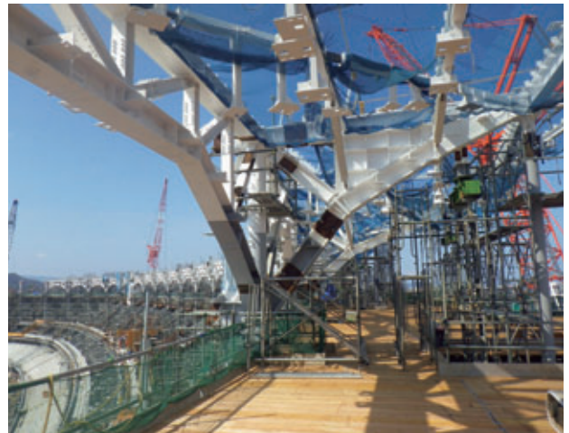
写真一6 外端部ベント（張出トラス受け）
