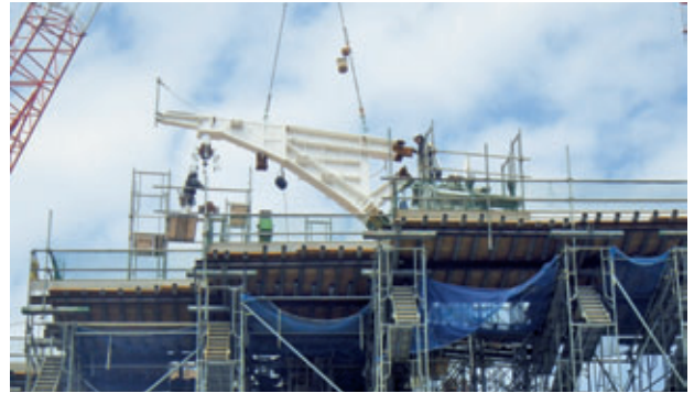
写真-3 張出トラス建方状況
