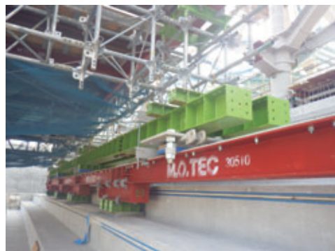
写真-14 軌条梁と走行設備
