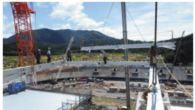
写真-5 フィールドトラス繋ぎ梁取付状況
