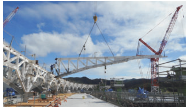
写真-4 フィールドトラス建方状況
