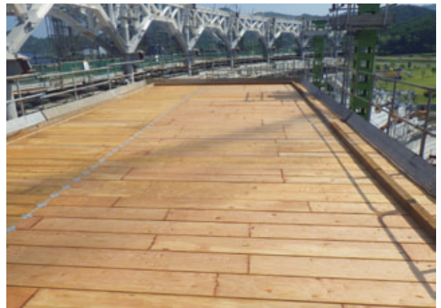
写真-12 移動ステージ作業床状況
