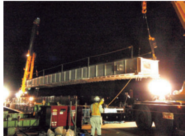
写真-1 A部新桁架設
