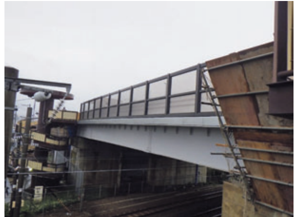
写真-13 架替完了
