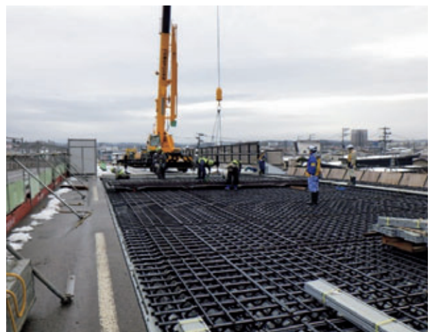
写真-4 A・B部グレーチング床版架設
