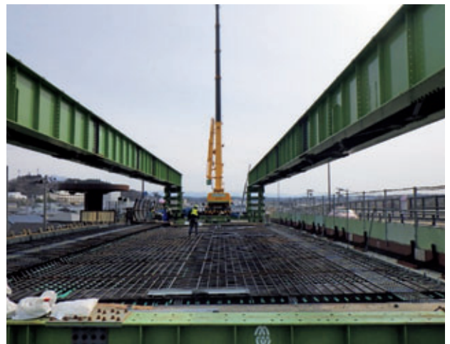
写真-12 C・D部グレーチング床版架設
