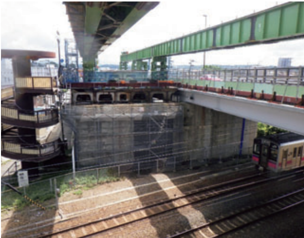
写真-8 B・C部既設桁撤去完了
