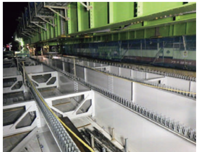
写真-3 B部新桁架設
