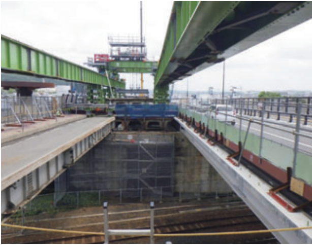
写真-7 D部既設桁撤去完了
