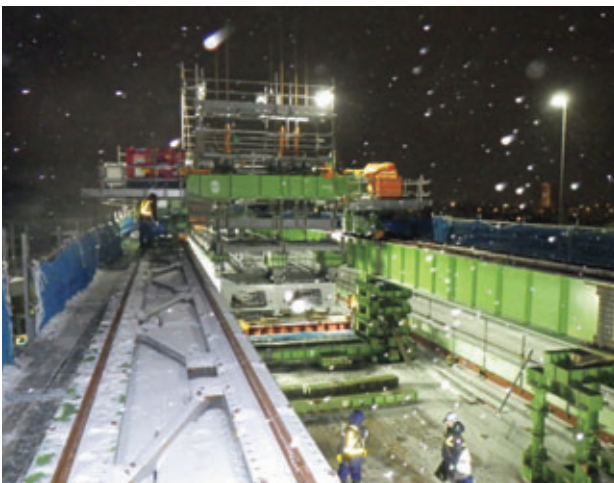
写真-9 D部補修桁架設
