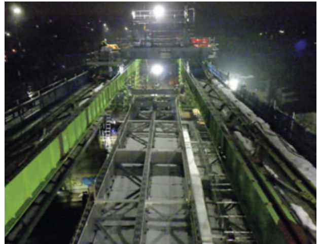
写真-11 C部新桁架設完了
