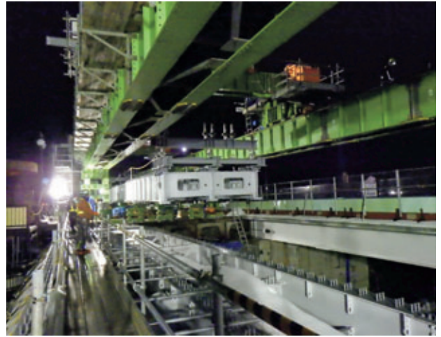
写真-10 C部新桁架設
