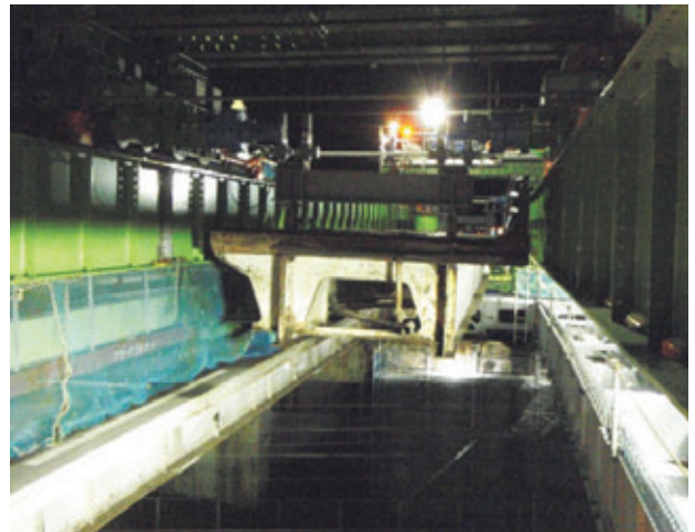
写真-2 B部既設桁撤去
