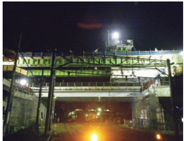
写真-6 C部既設桁撤去
