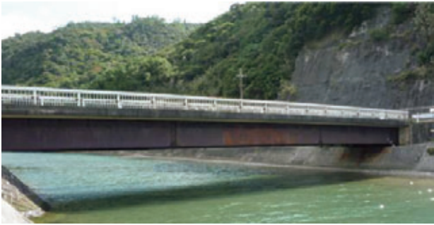
写真-1 対象橋梁の全景
