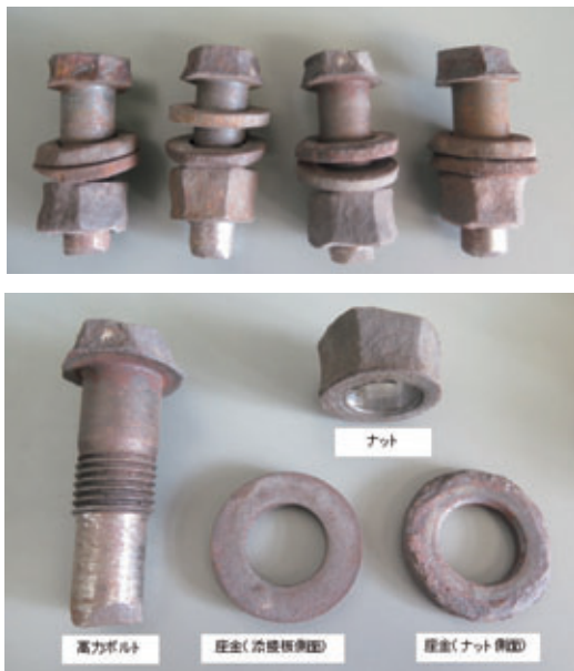
写真-2 高力ボルトの腐食状態
