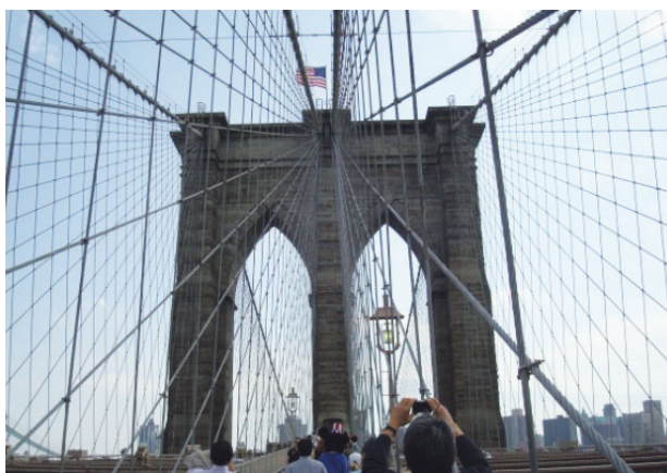
写真-3 ブルックリン橋主塔部の斜めケーブル
