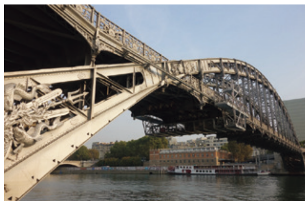
図-8 オステルリッツ高架橋外観 (10/17撮影)
