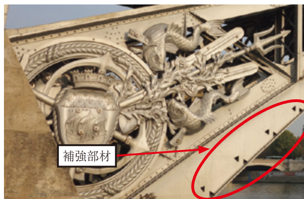
図-9 アーチ部材の装飾と補強材 (10/17撮影)
