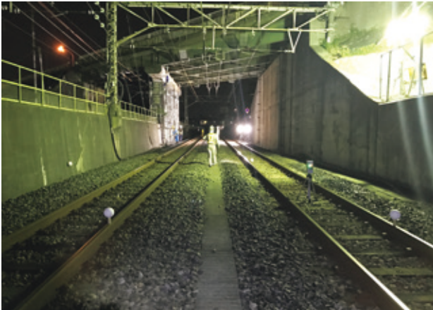
写真-8 橋梁側面
