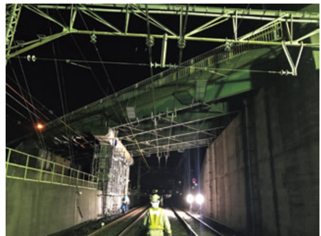
写真-1 3次元計測対象橋梁
