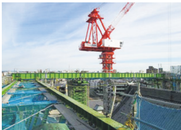
写真-9 工事桁上架完了
