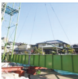
写真-7 工事桁玉掛
