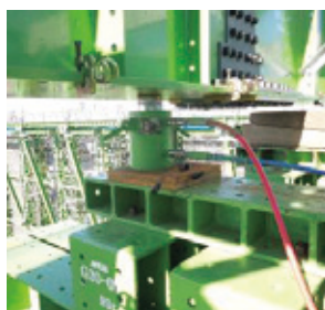
写真-10 ジョイント部
