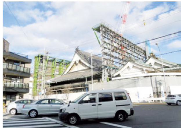
写真-20 トラス柱とベント支柱組立完了
