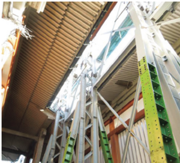
写真-2 狭いスペースに建つトラス柱
