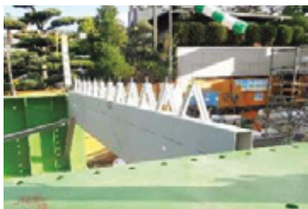
写真-18 タイトフレーム取付
