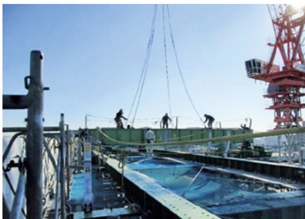
写真-8 工事桁上架
