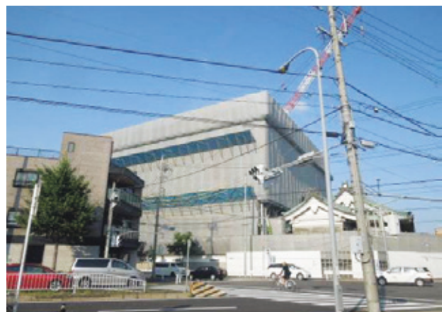
写真-22 完成時全景
