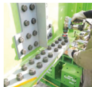
写真-11 本締状況
