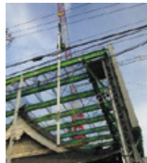
写真-16 8通り妻面の間柱取付
