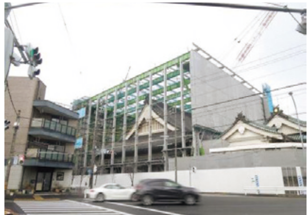
写真-21 工事桁スライド・間柱取付完了
