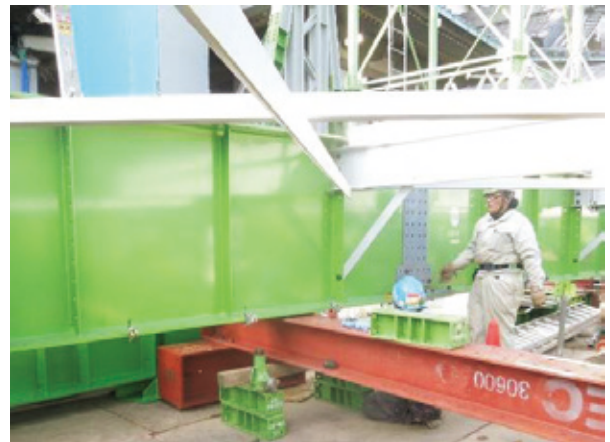
写真-17 組立キャンバー調整作業
