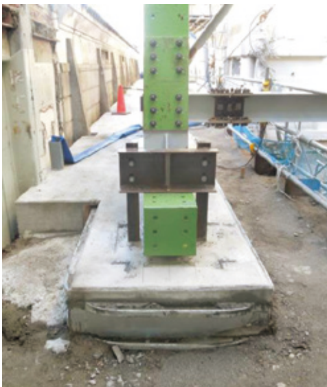
写真-3 トラス柱脚部
