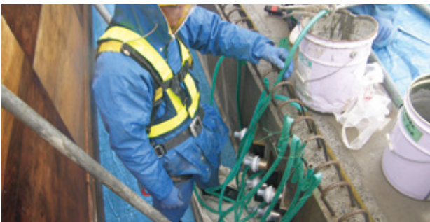
写真-22 PCグラウト注入状況
