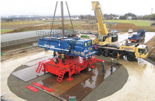
写真-4 クレーン本体組立
