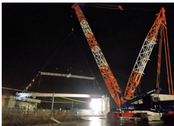
写真-14 桁架設状況
