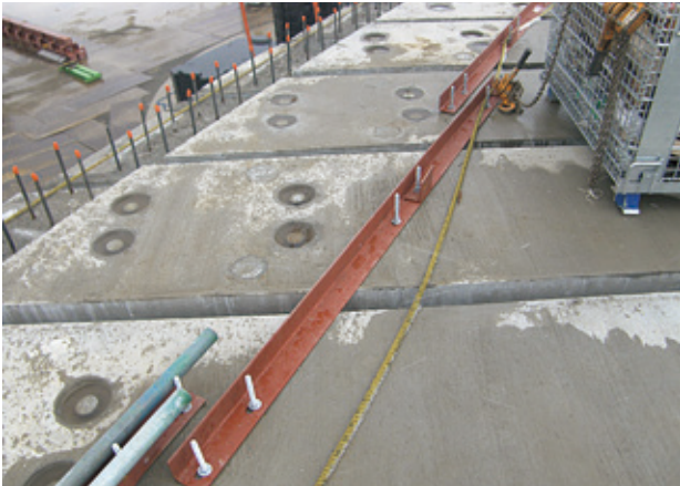
写真-16 桁上転倒防止処置
