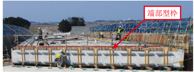
写真-17 端部型枠設置状況
