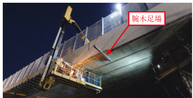
写真-23 床面撤去状況
