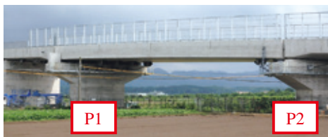
写真一 工事完了全景
