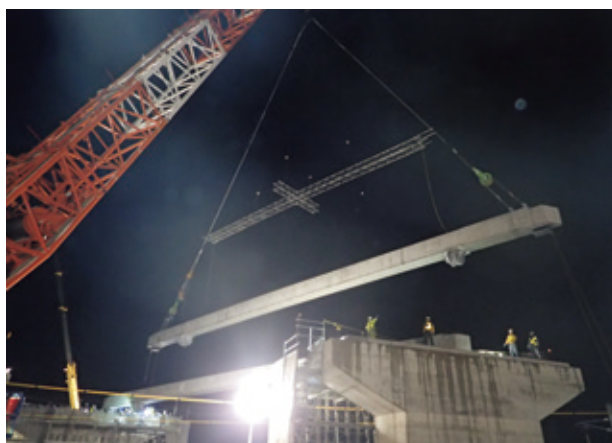
写真-15 桁架設状況
