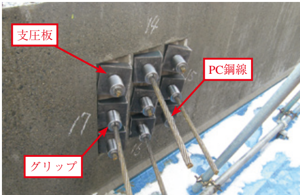
写真-20 PC鋼線・支圧板設置完了
