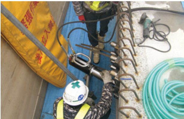
写真-21 PC横締め緊張
