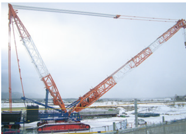
写真-2 500t吊クローラクレーン
