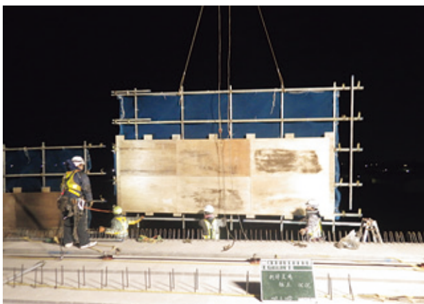
写真-10 朝顔パネル設置状況
