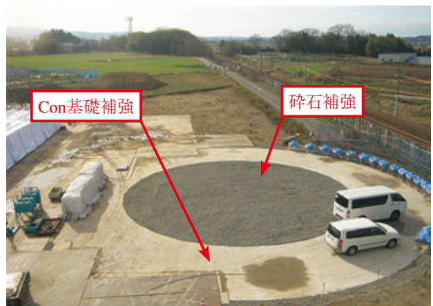
写真-3 コンクリート基礎
