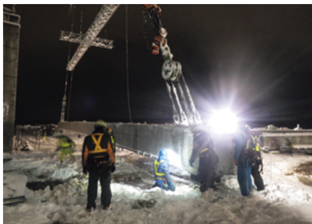
写真-13 主桁仮置き状況
