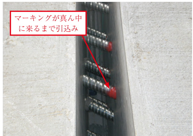
写真-18 シース管設置状況
