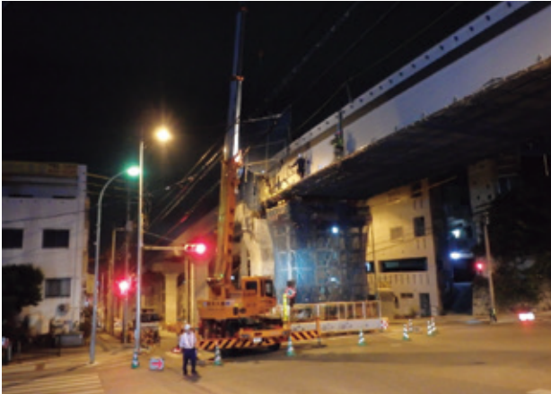
写真一五 吊足場設置状況
