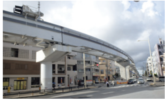
写真-13 P586-P587 着工後
