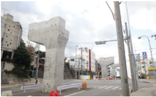
写真-14 P594-P595 着工前
