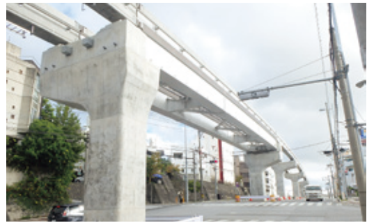
写真-15 P594-P595 着工後
