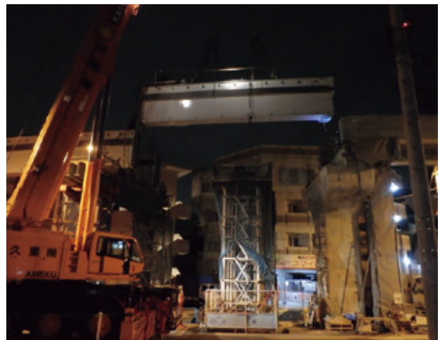
写真-4 単材主桁架設状況
