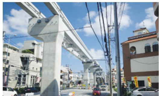
写真-19 P618-P619 着工後
