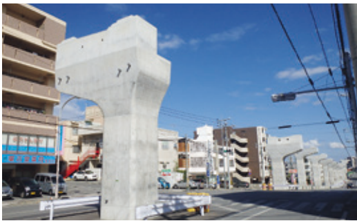
写真-16 P607-P608 着工前
