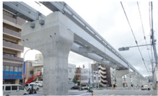
写真-17 P607-P608 着工後
