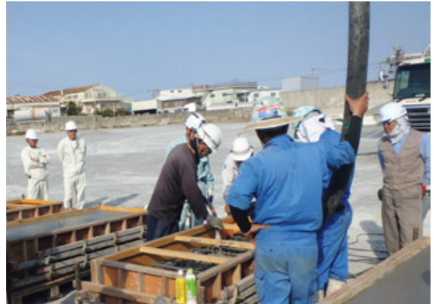
写真一七 施工試験（圧送状況）
