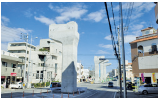
写真-18 P618-P619 着工前
