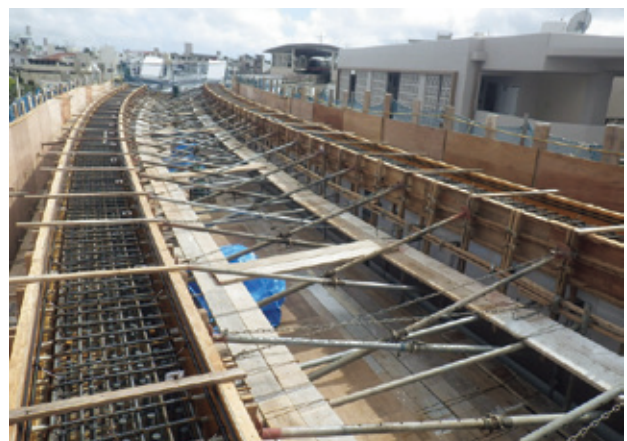
写真一九 櫛付き型枠
