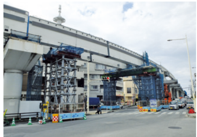
写真-1 ベント設備設置状況
