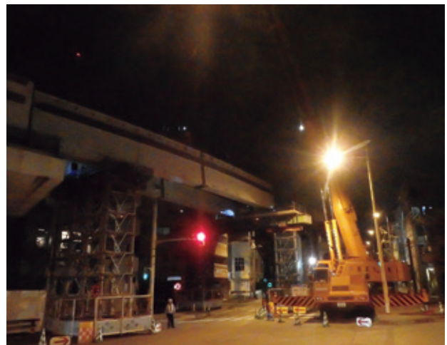
写真-3 地組主桁架設状況
