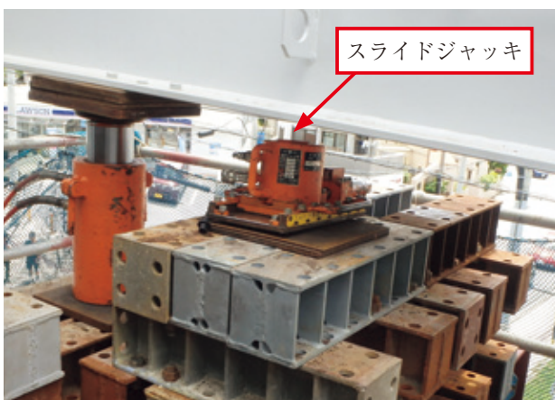
写真-10 橋軸直角方向主桁調整時
