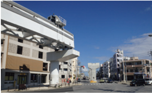
写真-12 P586-P587 着工前
