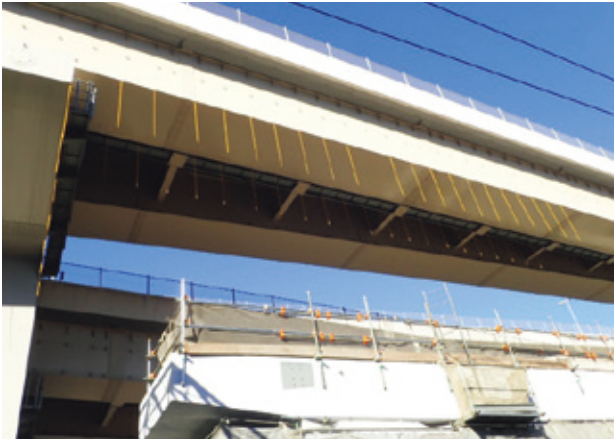
写真-13 プラスチックチェーン設置状況
