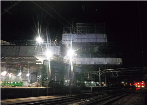
写真-10 J4-J5ブロック架設状況
