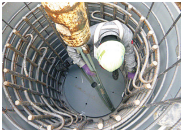
写真-7 固定ベースプレート設置状況
