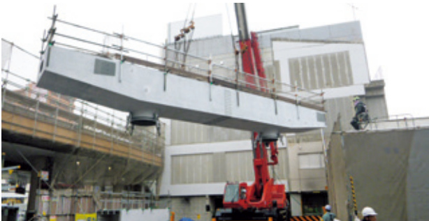
写真-9 橋脚横梁架設状況
