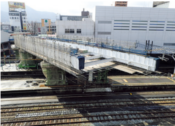
写真-11 J4-J5ブロック架設完了状況
