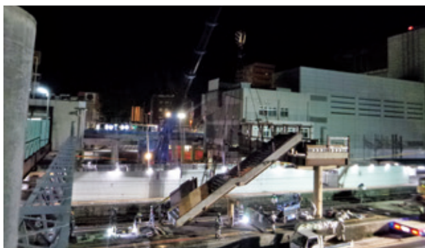
写真-5 階段桁撤去状況
