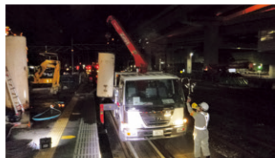
写真-3 部材搬出状況
