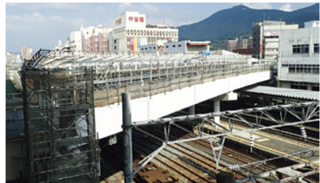
写真-17 桁架設完了状況
