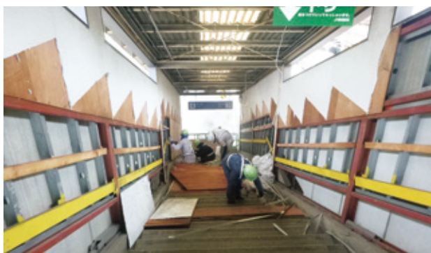
写真-4 階段桁内装解体状況
