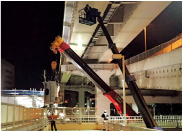
写真-14 離隔確認状況
