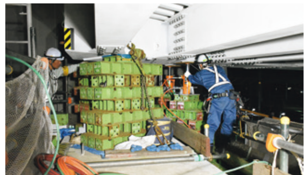
写真-16 桁ジャッキダウン施工状況
