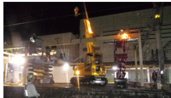
写真-2 上屋撤去状況
