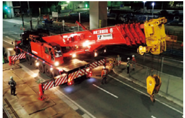
写真-12 クレーン据付状況
