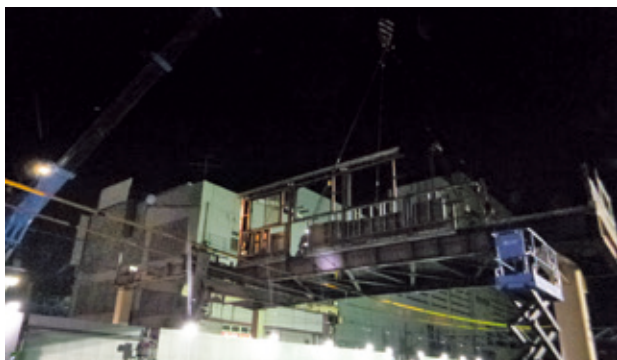
写真-6 乗換跨線橋撤去状況
