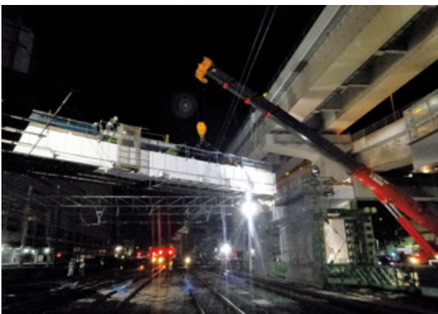
写真-15 J5-GE2ブロック架設状況
