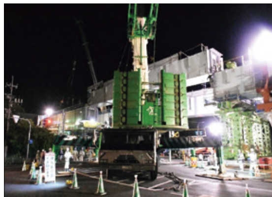
写真-4 G2桁落とし込み架設状況
