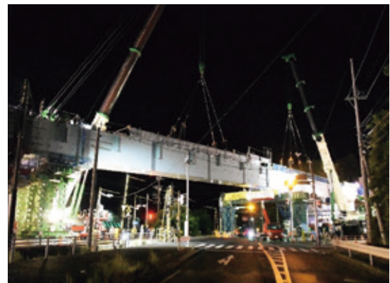
写真-3 G1桁落とし込み架設状況
