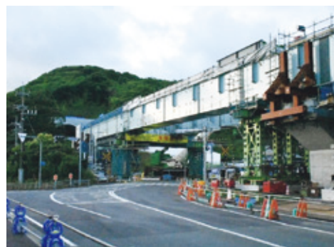
写真-2 架設完了
