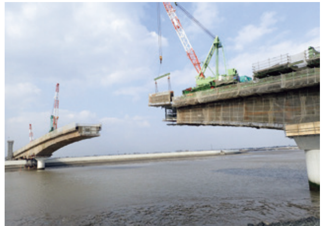
写真-8 堤外地架設状況
