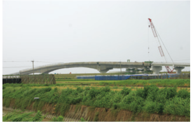
写真-13 桁端部ブロック架設要領
