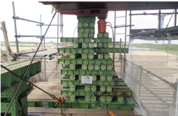
写真-11 A1橋台ジャッキアップ架台
