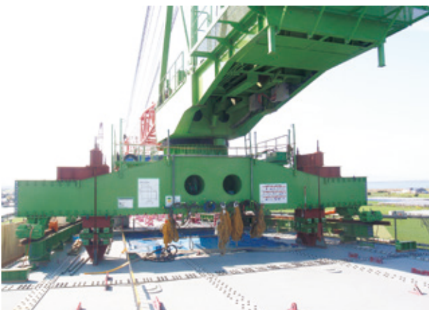
写真-7 トラベラクレーン基部
