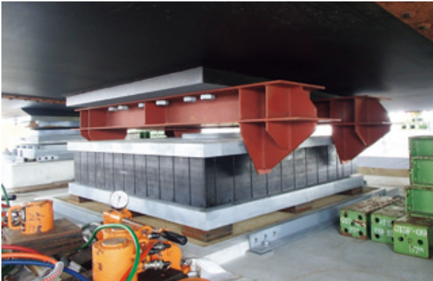
写真-10 P5支点部安全対策
