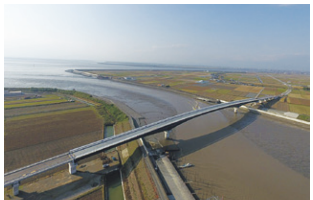
写真-14 完成写真
