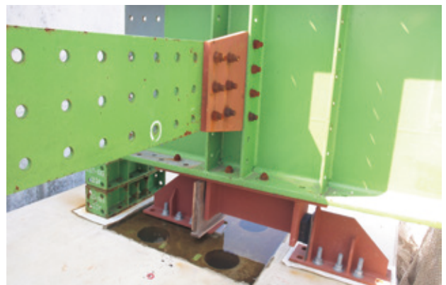
写真-5 端部支点（仮桁）安全対策
