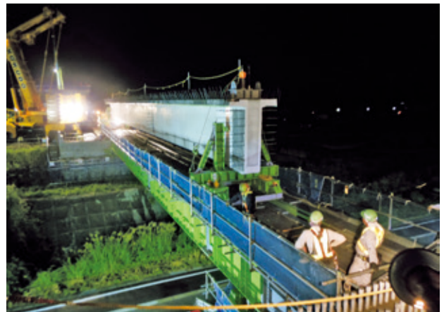
写真一5 主桁縦取り状況
