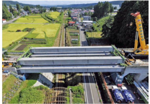
写真-12 G3、G4桁仮置き状況
