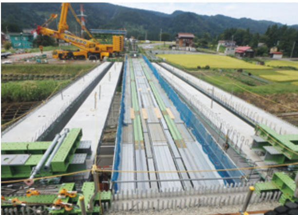
写真-10 G1, G2, G5, G6架設完了
