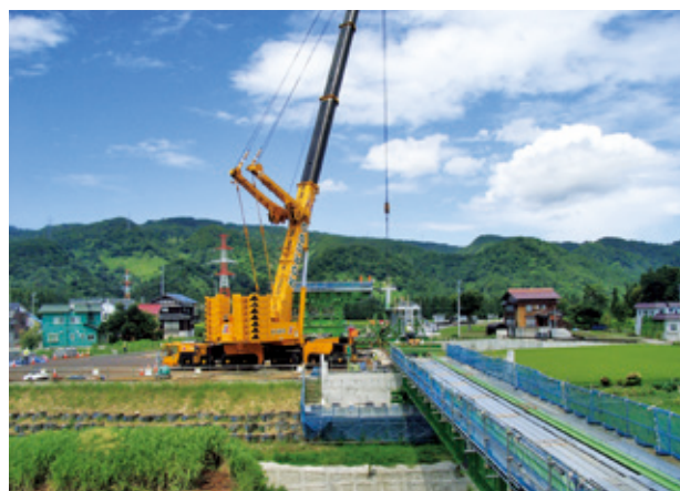
写真-2 主桁組立状況
