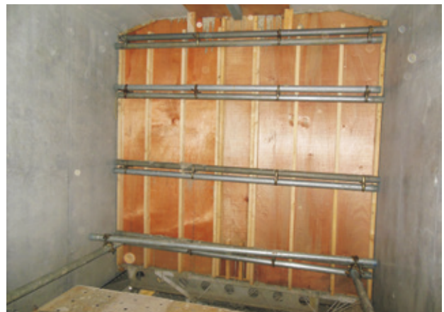
写真-9 横桁部型枠
