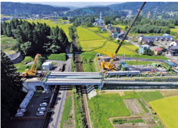
写真-11 G3桁組立状況
