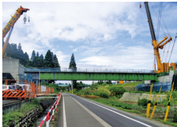
写真-1 架設桁架設完了
