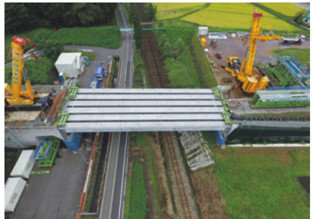
写真-13 主桁架設完了
