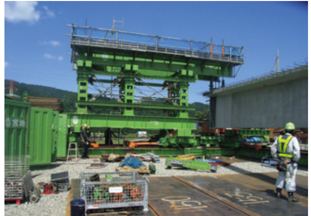
写真一4 主桁吊上横取り設備
