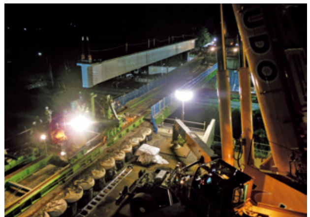
写真一6 主桁架設状況
