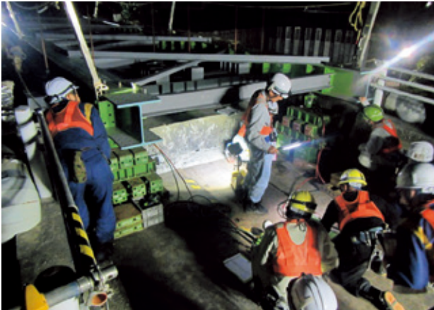
写真-10 桁ジャッキアップ・縁切り
