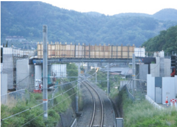
写真-6 新設桁架設完了
