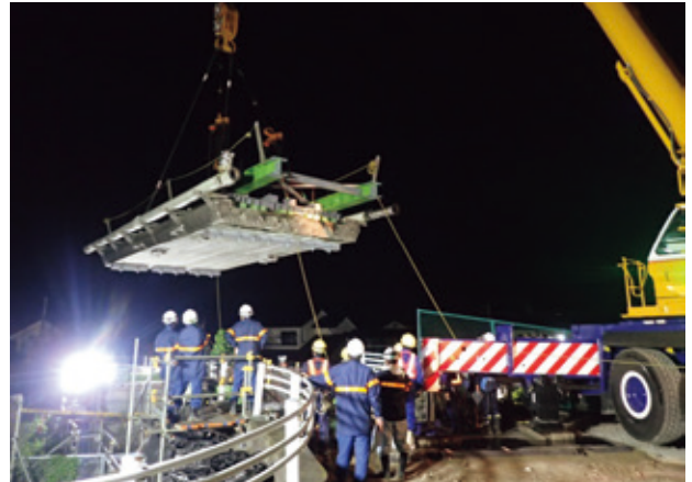
写真-12 既設桁撤去作業状況 (2)
