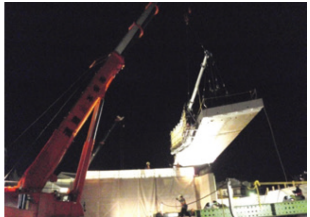
写真三 ①ブロック架設
