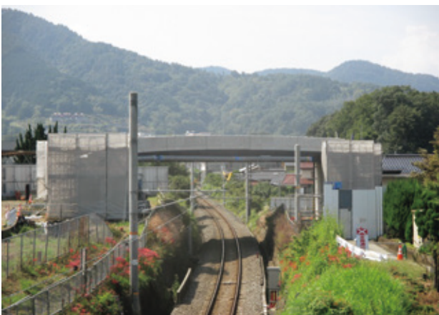
写真-7 新設桁施工完了
