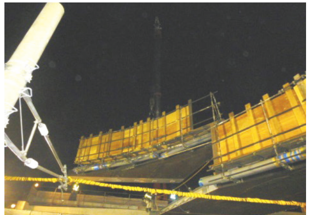
写真四 ②ブロック架設
