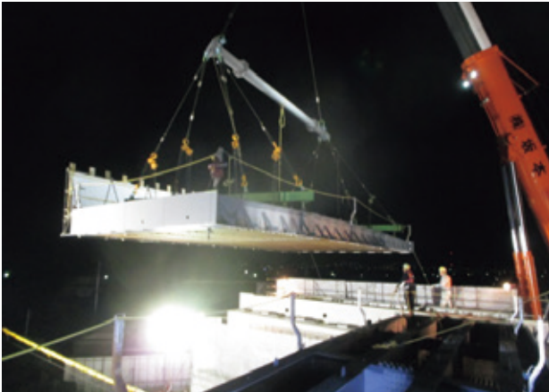
写真-5 ③ブロック架設
