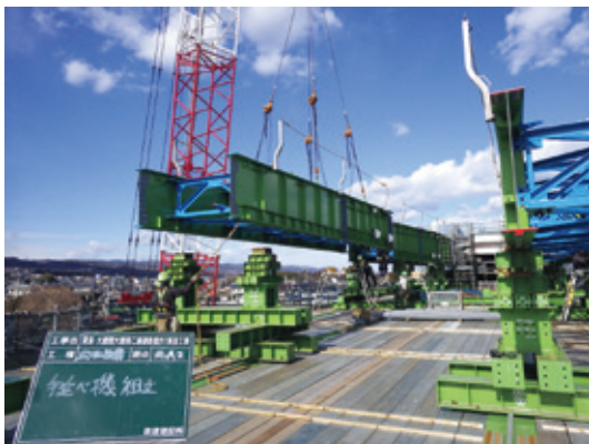
写真-3 手延べ機組立
