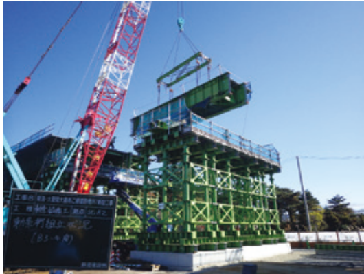
写真-1 軌条設備組立
