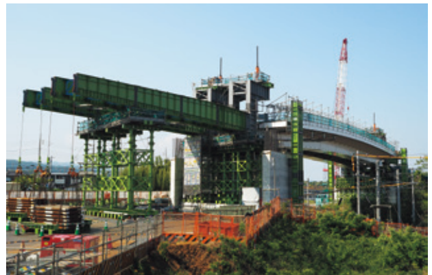
写真一〇 降下完了状況
