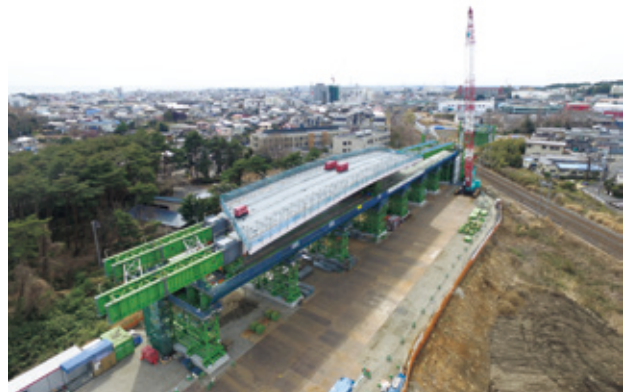
写真-4 本設桁・手延べ機・後方桁組立完了
