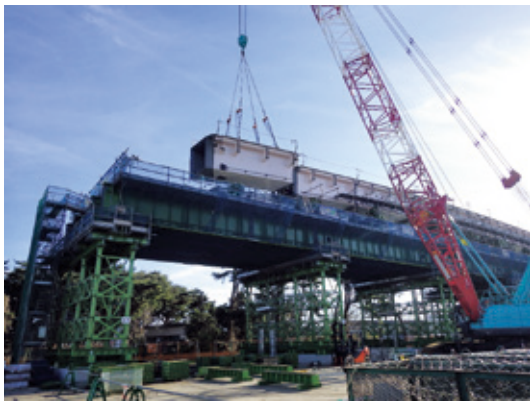
写真-2 本設桁組立
