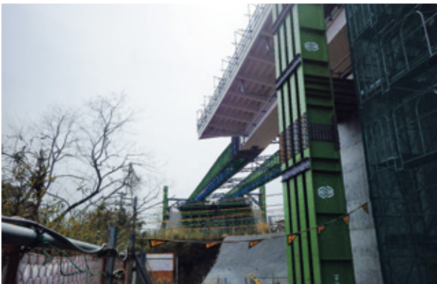
写真一八 手延べ機到達完了
