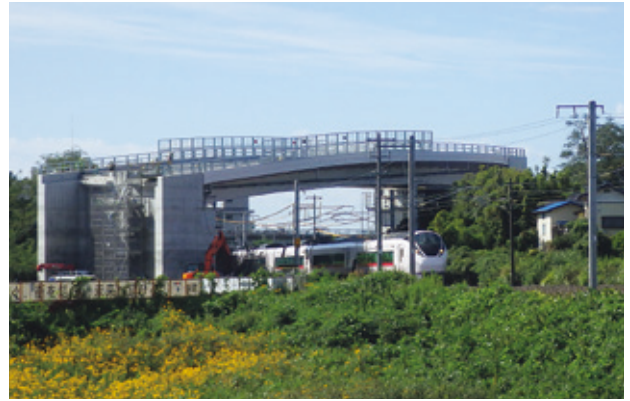
写真-13 架設完了
