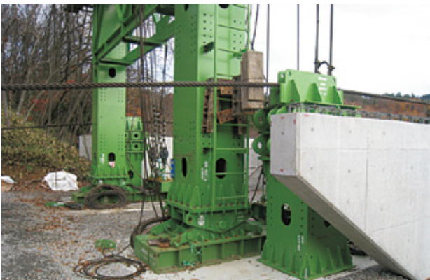
写真-6 A2側コンクリート直接基礎
