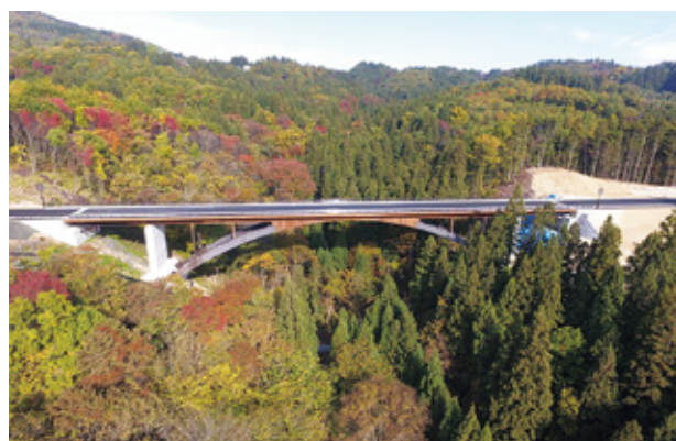
写真-14 三念沢橋梁開通（全景）
