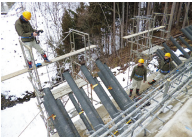
写真-3 上部工アンカーボルト据え付け後計測状況
