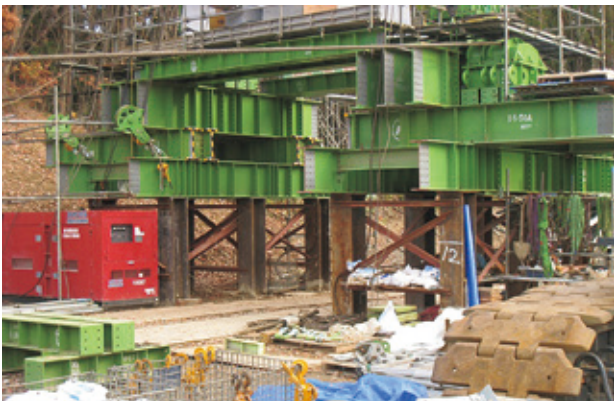
写真-5 A1側杭基礎
