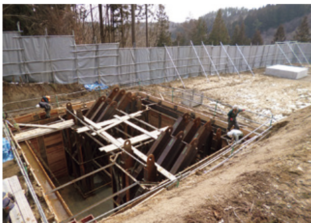
写真-10 A1側コンクリートアンカー施工
