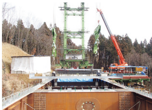
写真-12 合成床版鋼製パネル架設状況
