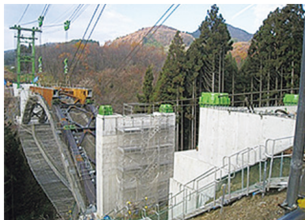
写真-4 アーチ部材の斜吊り設備
