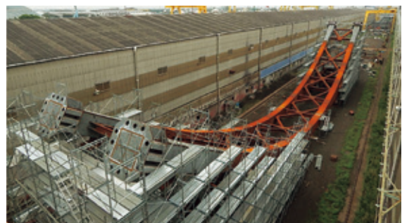
写真-1 アーチ部材の倒立一体仮組立
