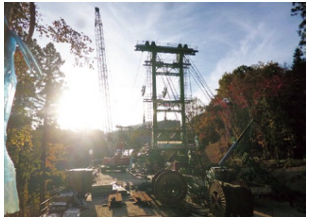
写真-7 A1側仮設構台
