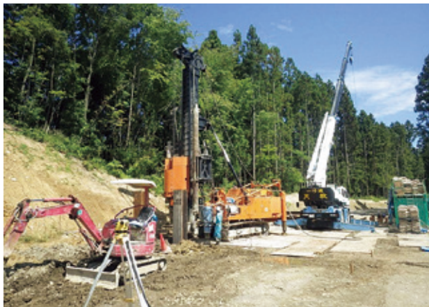
写真-9 A1側杭基礎施工 (ALEX工法)
