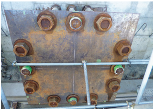
写真-2 アンカーボルト間隔保持材
