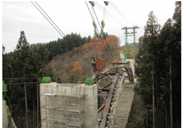
写真-8 隅角部相吊り架設
