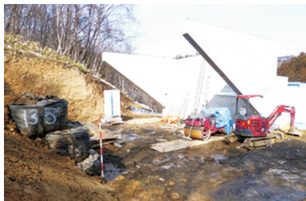
写真-11 A2側コンクリート基礎部地盤改良施工
