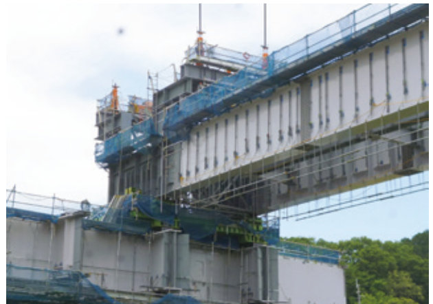
写真－9 剛結部連結構（桁降下時）
