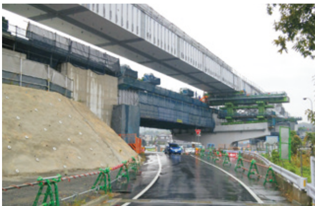
写真-15 横取り状況
