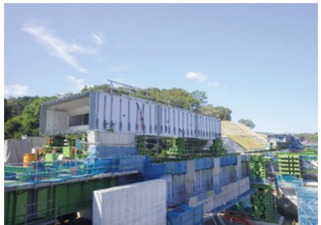
写真-12 縦取りブロック（箱桁部）
