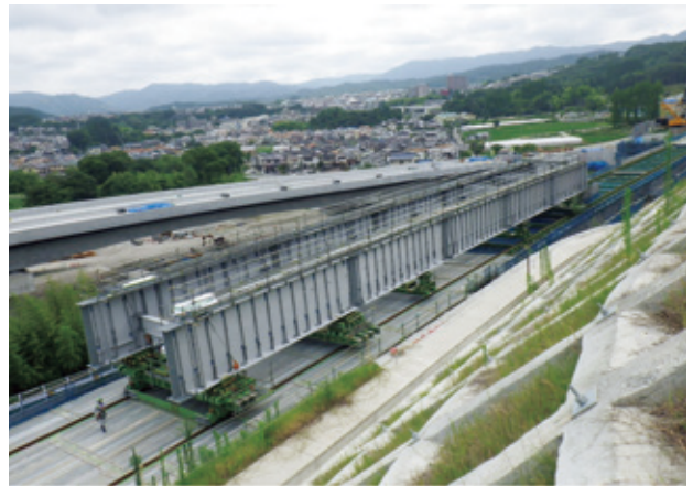
写真-11 縦取りブロック（鈹桁部）
