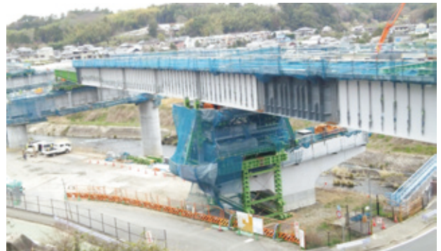
写真－8 剛結部連結構（送り出し架設時）
