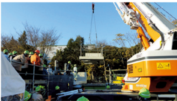
写真一6 公開施工試験
