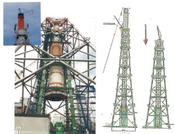
写真-5 磯子火力発電所高層煙突解体
