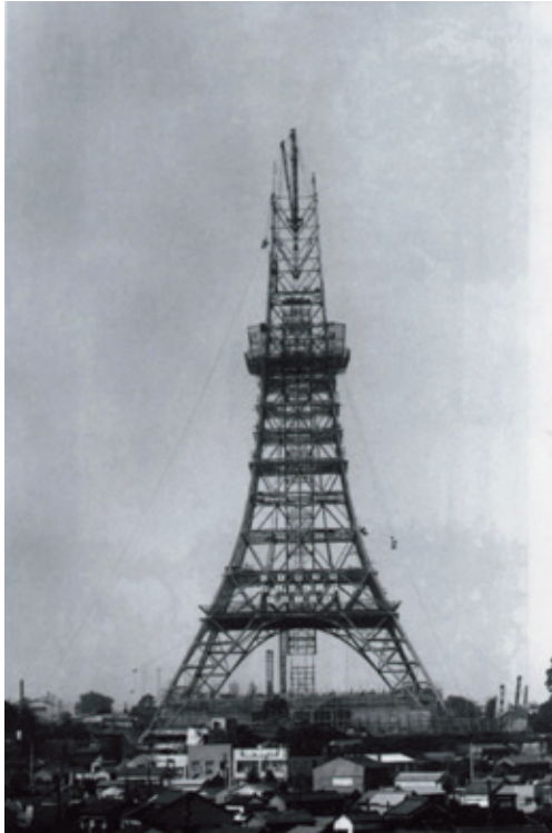
写真-1 建設中の東京タワー
